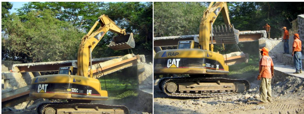
FIG 5.1 Y 5.2 DEMOLICION DE PUENTE EXISTENTE.
