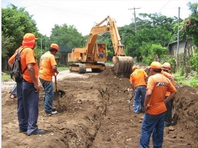
FIGURA 5.4 SOBREEXCAVACION
