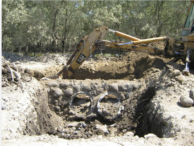
FIGURA 5.10 EXCAVACION PARA OBRA DE PASO
