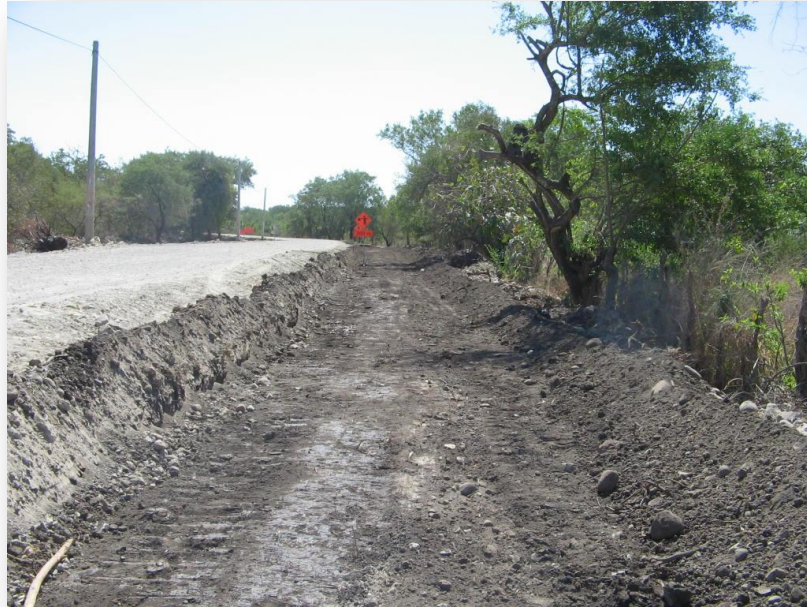
FIGURA 5.3 EXCAVACION DE LA VIA
