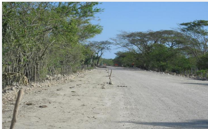
FIGURA 5.9 ACABADO DE LA SUPERFICIE.
