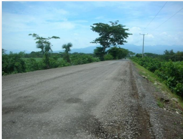
FIGURA 5.13 COLOCACION DE BASE
