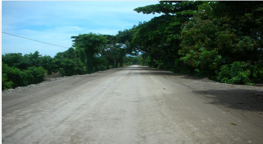
FIGURA 5.11 TRAMO DE SUBRASANTE CONFORMADA
