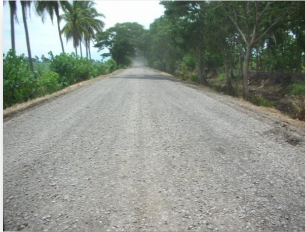
FIGURA 5.12 SUBBASE CONFORMADA
