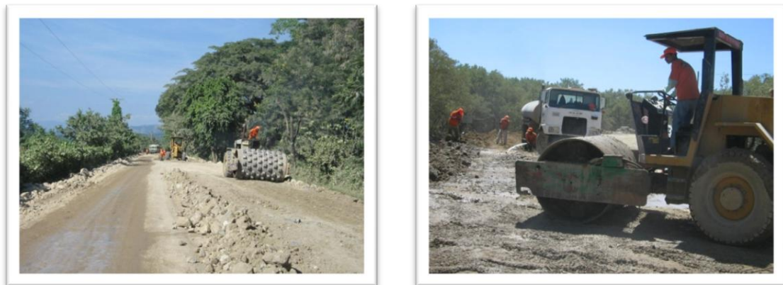
FIGURA 5.7 Y 5.8 COMPACTACION DE TERRAPLEN
