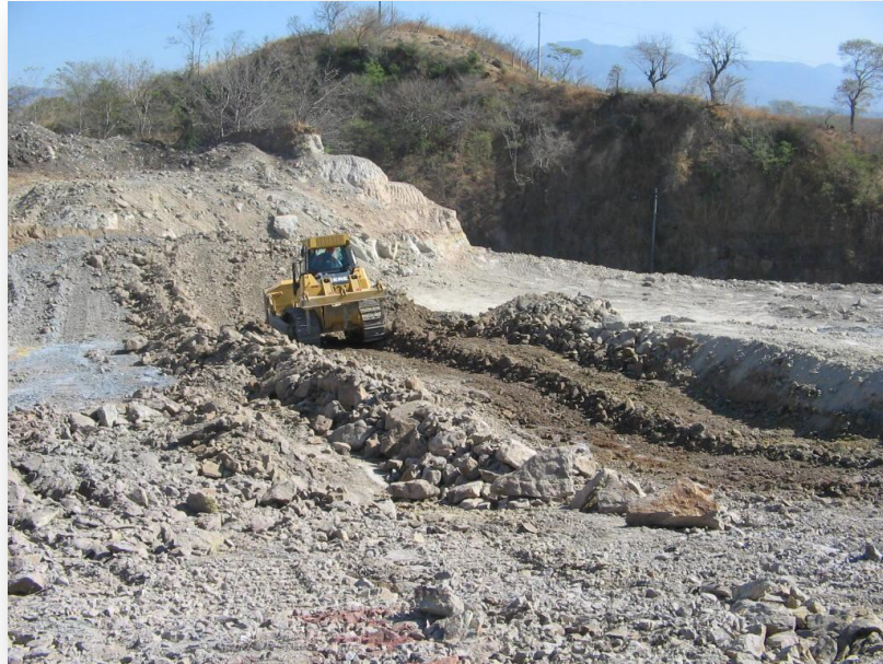
FIGURA 5.5 EXCAVACION DE MATERIAL DE PRESTAMO
