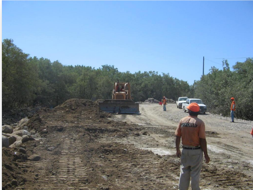
FIGURA 5.6 TERRAPLANEO DE LA VIA
