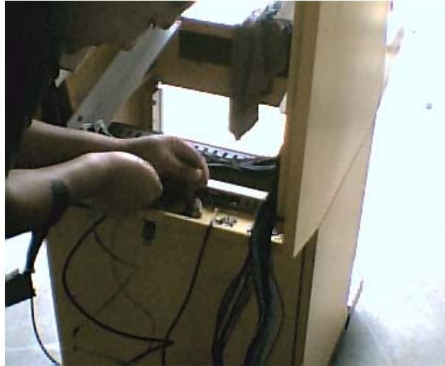
Figura 3.14. Revisión de las conexiones de los conductores del panel de control.
