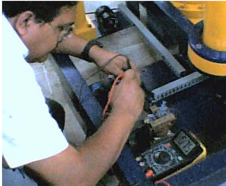
Figura 3.18. Revisión, prueba y medición del circuito electrónico de disparo del generador de impulsos.
