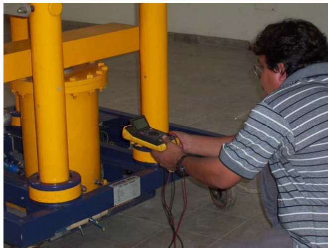
Figura 3.32. Prueba del transformador elevador de voltaje.
