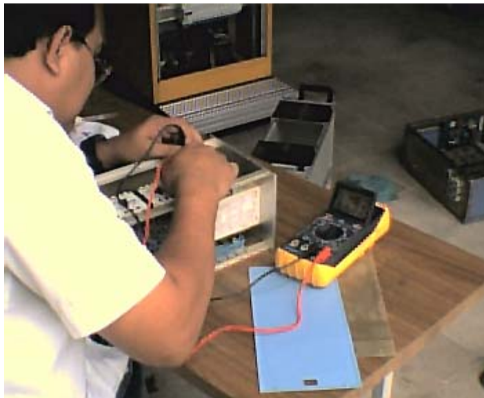
Figura 3.23. Una pequeña revisión y medición de los elementos que contiene la tarjeta, de la unidad de control del espinterometro de medición. Se observo que a la tarjeta se encontraba en buenas condiciones.
