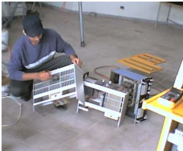
Figura 3.11. Limpieza de cada uno de los módulos que forman panel de control
