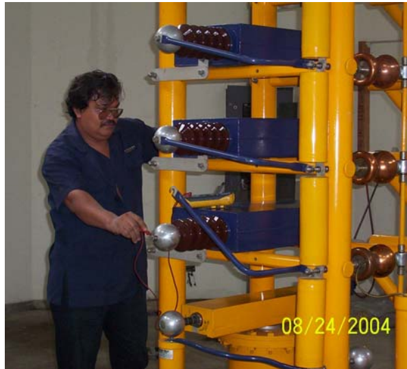
Figura 3.31. Descarga de los capacitores.
