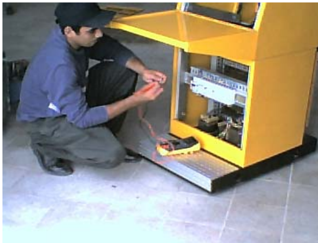
Figura 3.15. Revisión y prueba de cada uno de los fusibles que tiene el modulo de control.
