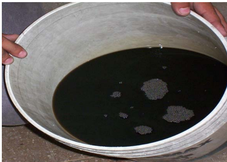
Figura 3.36. Aceite aislante dañado
