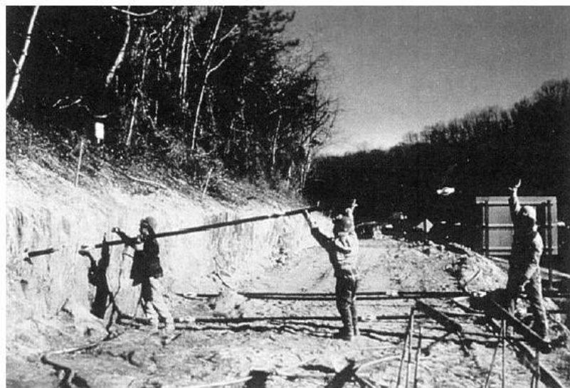
Figura 3. 9 Levantamiento de excavación inicial e instalación de anclaje.
