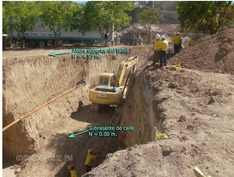
Figura 4. 1 Proceso de excavación.
