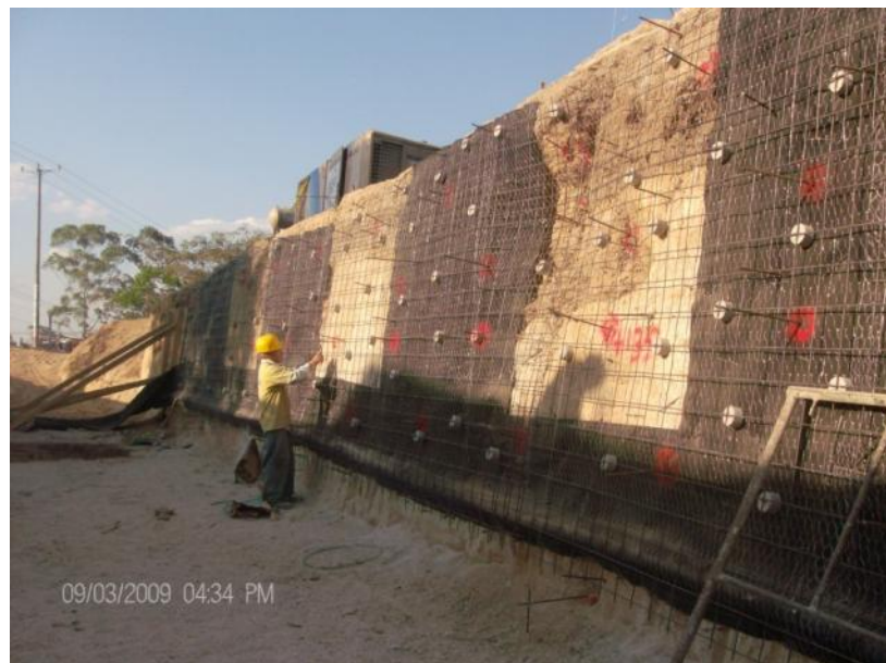
Figura 4. 8 Instalación de malla electro soldada.
