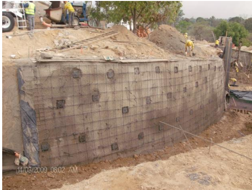
Figura 4. 17 Proceso de colado para revestimiento permanente de muro de tierra armada.
