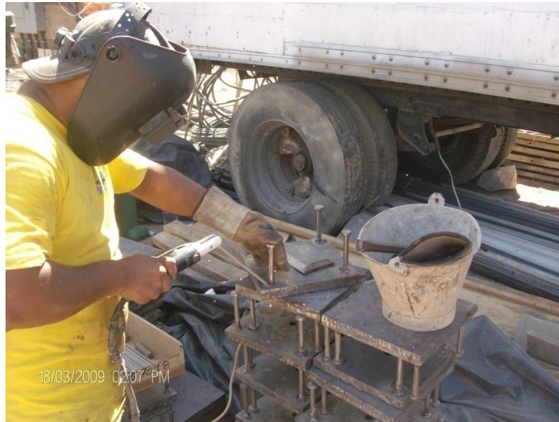
Figura 4. 14 Soldadura de nelson stud con placa de anclaje.
