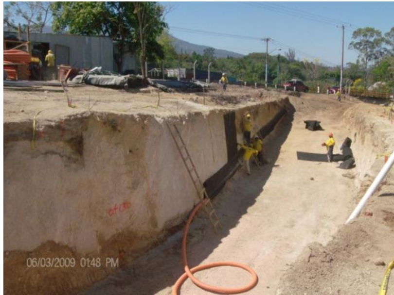
Figura 4. 7 Colocación de geotextil.
