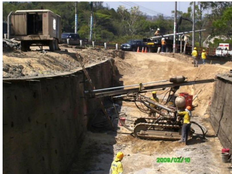
Figura 4. 9 Equipo trabajando en perforación para anclajes.
