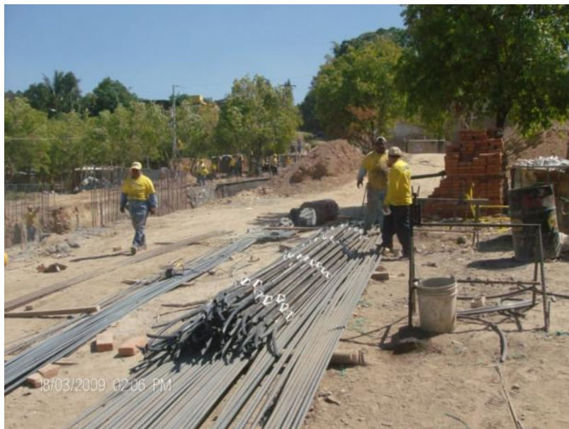
Figura 4. 12 Vista de barras de acero con poliducto y centradores.
