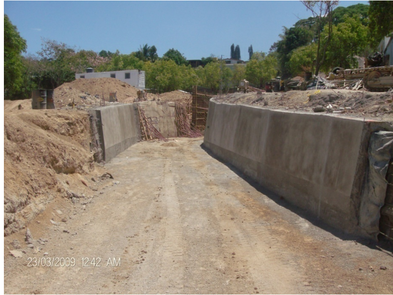
Figura 4. 18 Tramo de muro finalizado.
