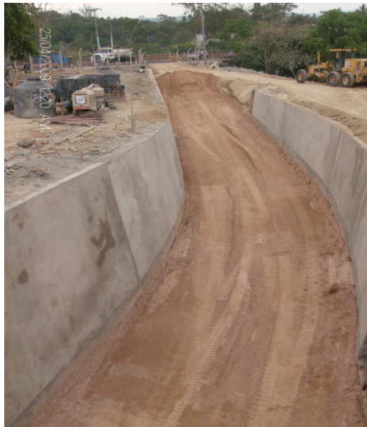
Figura 4. 19 Base de pavimento con taludes laterales estabilizados con Soil Nailing.
