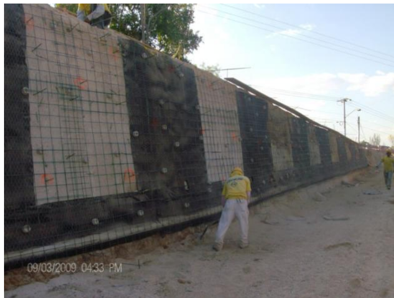
Figura 4. 15 Instalación terminada de drenaje y electro malla en talud.
