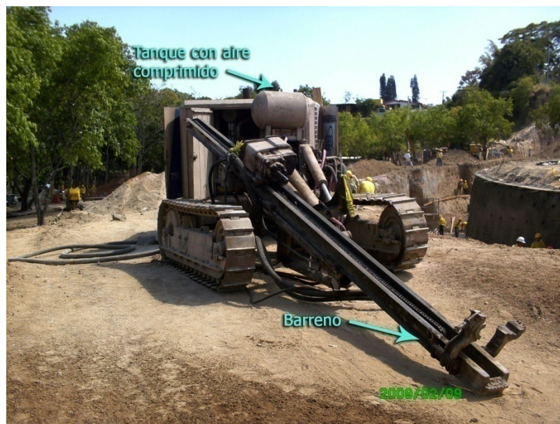
Figura 4. 3 Equipo para perforación.
