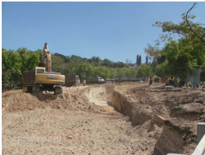
Figura 4. 2 Excavación en el terreno.
