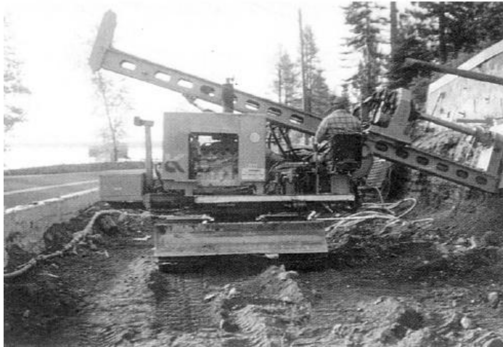
Figura 3. 11 Perforación típica de anclajes con el método rotatorio.
