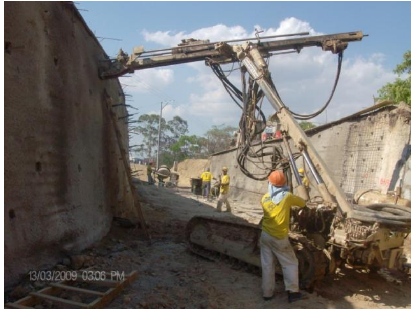
Figura 4. 10 Drill trabajando en la perforación para un anclaje.
