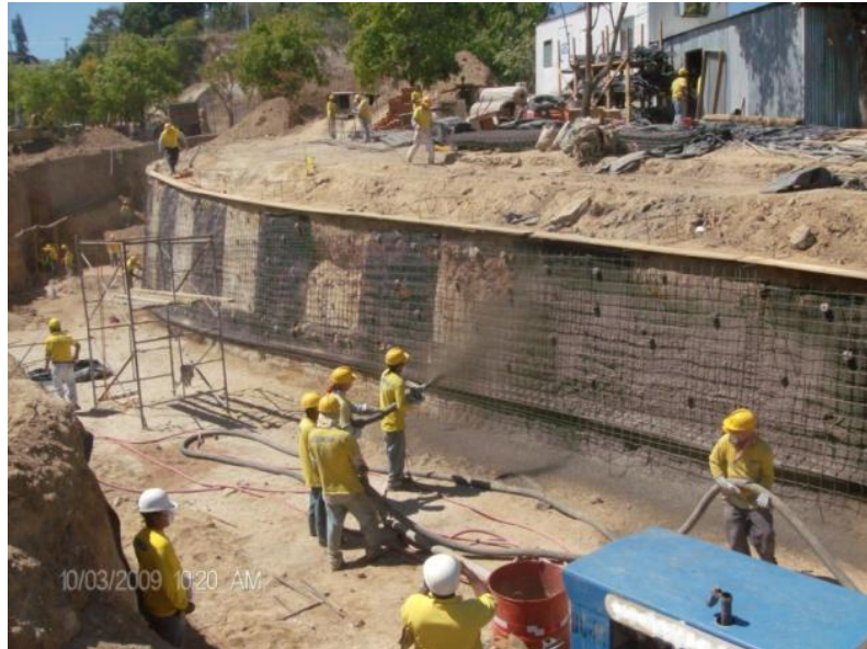
Figura 4. 16 Proceso de colado para revestimiento temporal de muro de tierra armada.
