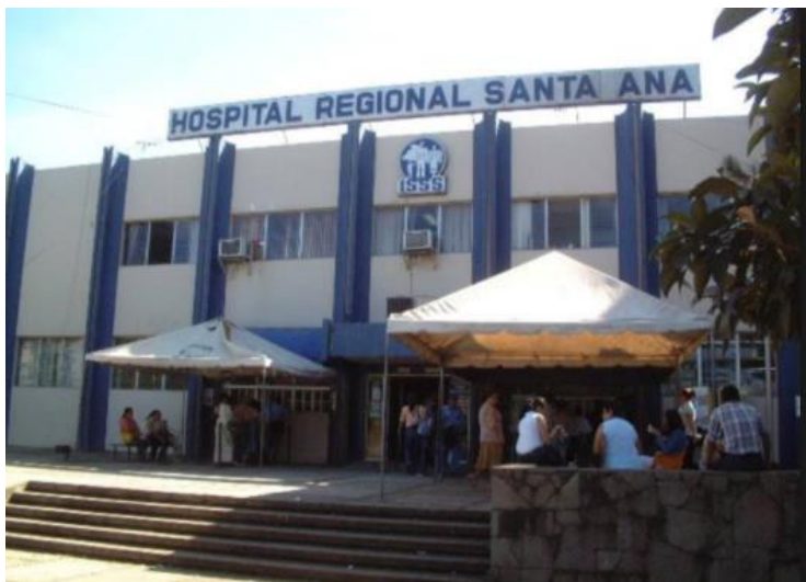
Ilustración 79 Entrada Hospital Regional ISSS Santa Ana
