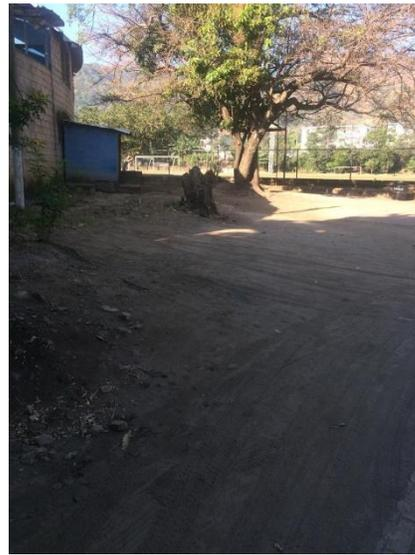
**Fotografía 4-9:** Superficie de rodadura de suelo natural compactado. Fuente: Elaboración propia.
