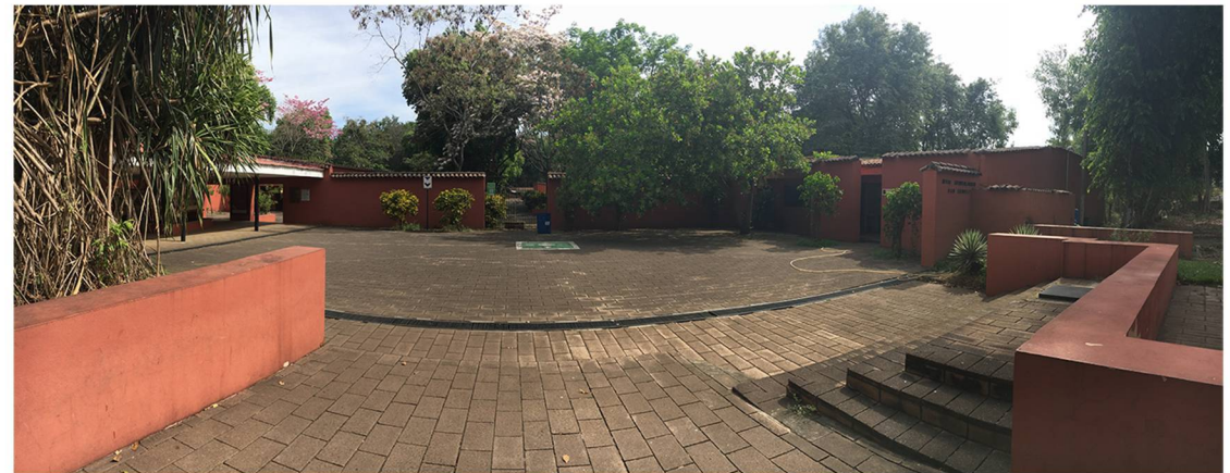
Vista desde acceso principal hacia vestibulo general, a la izquierda: zona de mapa arqueologico. A la derecha: edificio de baterias sanitarias y oficina de administrador.
