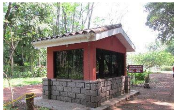
Imagen UR-05: Caseta de entrada Fuente: Orellana, D. 2019
