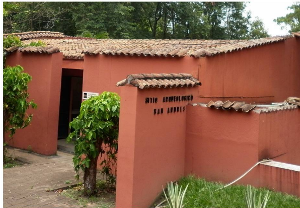
Vistas exteriores de Servicios Sanitarios para extranjeros
