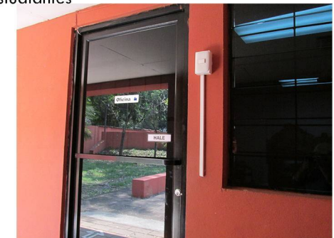
Vistas exterior de oficina administrativa
