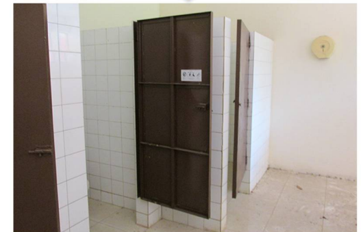
Vistas interior de Servicios Sanitarios para estudiantes
