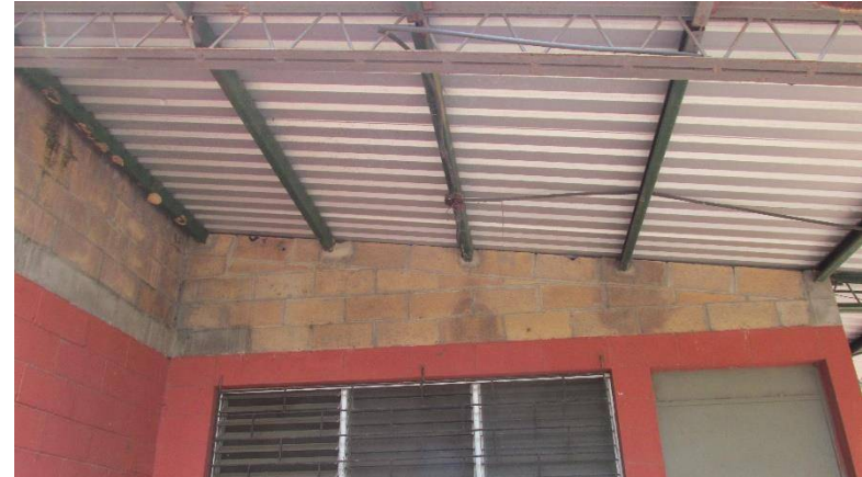
Imagen AR-06: Bodega de mantenimiento y Estar de investigadores Fuente: Orellana, D. 2019
