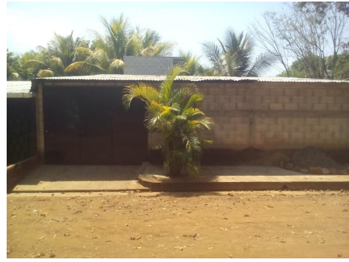
Fig.22. Vivienda del polígono 5, al sur del terreno.
