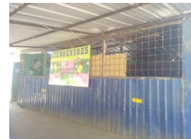
Fig. 6. Vista exterior de aulas provisionales
