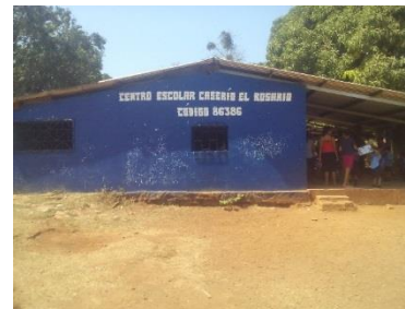
Fig. 3. Fachada lateral del Centro Escolar
