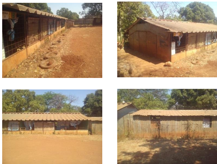
Fig. 7. Vistas exteriores de aulas provisionales
