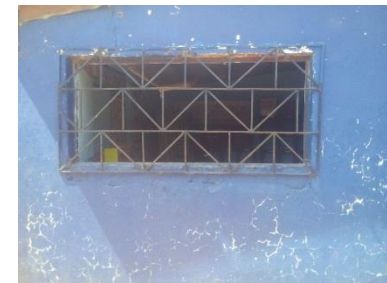
Fig. 4. Ventana del aula de parvularia
