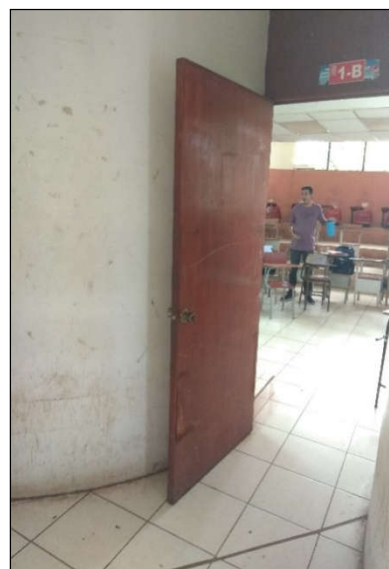
Ilustración 4.10 Vista general del Aula 1-B del Edificio Bunker
