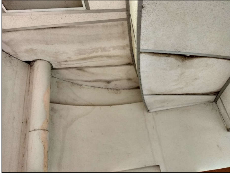
Ilustración 5.18 Condición de Cielos Falsos
