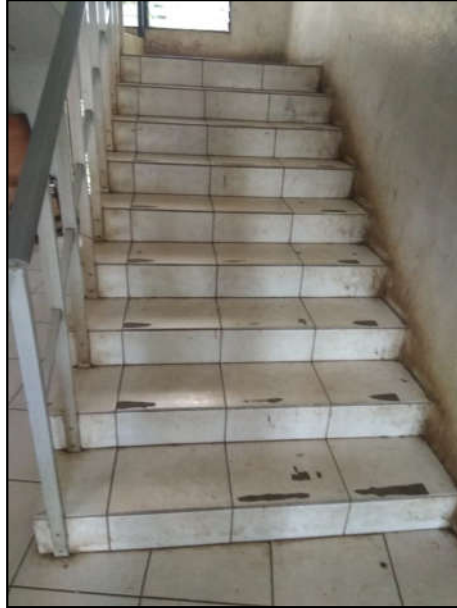
Ilustración 5.21 Gradas de acceso al segundo nivel del Edificio Bunker.
