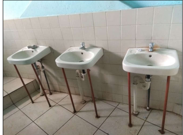
Ilustración 4.11 Vista general de los servicios sanitarios para hombre del nivel 1 del Edificio Bunker.
