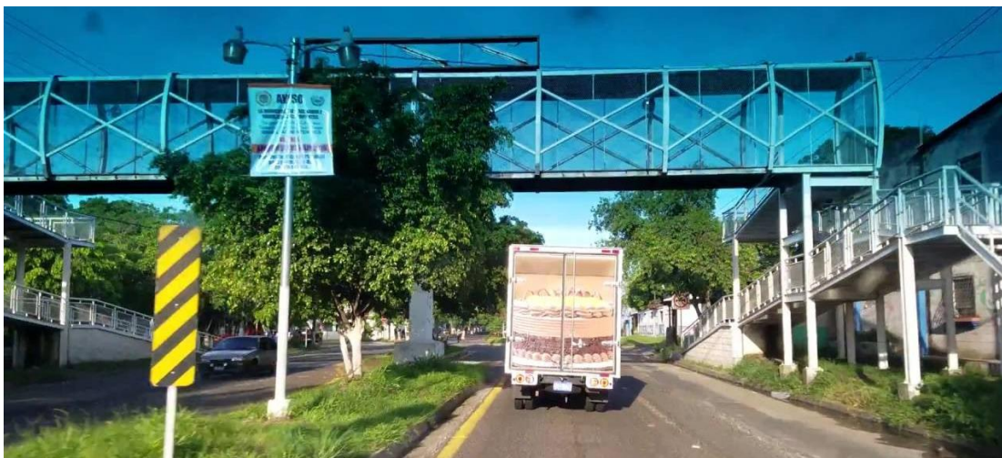
(Imagen 26) Pasarela Peatonal ubicada en la ciudad de Chalchuapa, frente al Hospital Nacional de la ciudad. Fuente: equipo investigador
