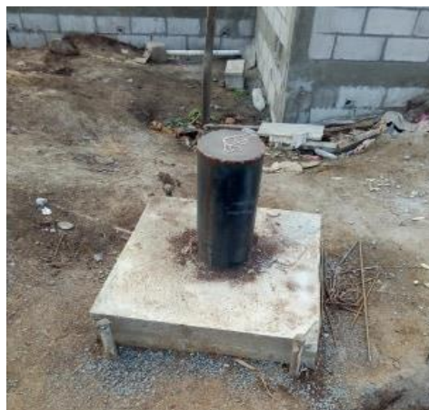
(Imagen.30) del pozo de agua potable perforado en febrero del año 2019 Fuente: equipo investigador.
