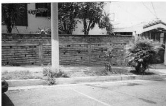
Figura 4.40 Muro perimetral de ladrillo de barro cocido en vivienda
