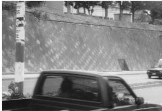
Figura 4.30 Muro para protección de talud en carretera
