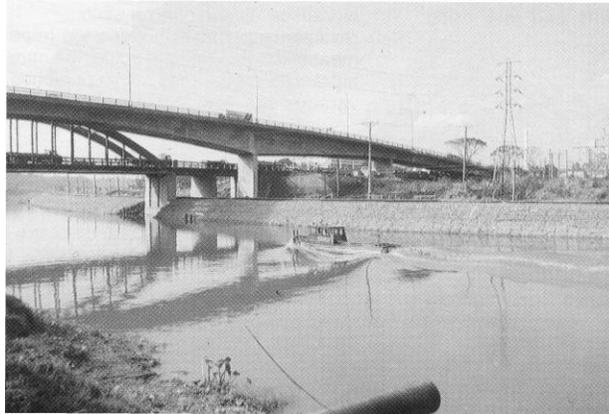
Figura 4.49 Protección de columnas de puente por medio de gaviones
