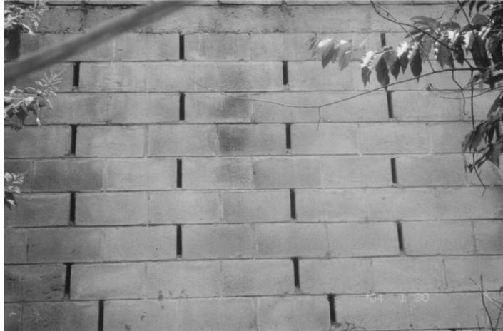
FIGURA No.2.47 Huecos para drenaje en muros de mampostería de bloques de concreto
