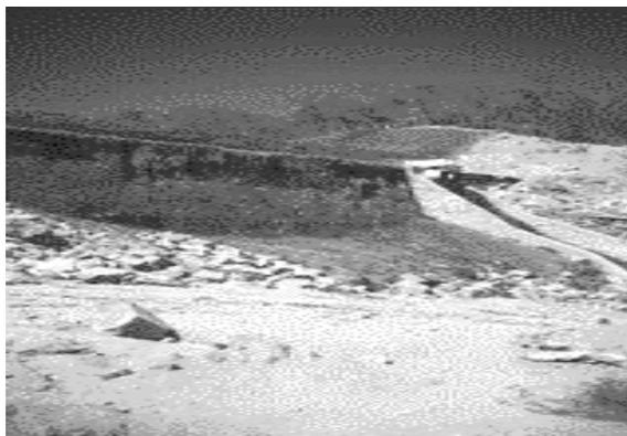
Figura 4.15 Terraplén con muro de mampostería de piedra
