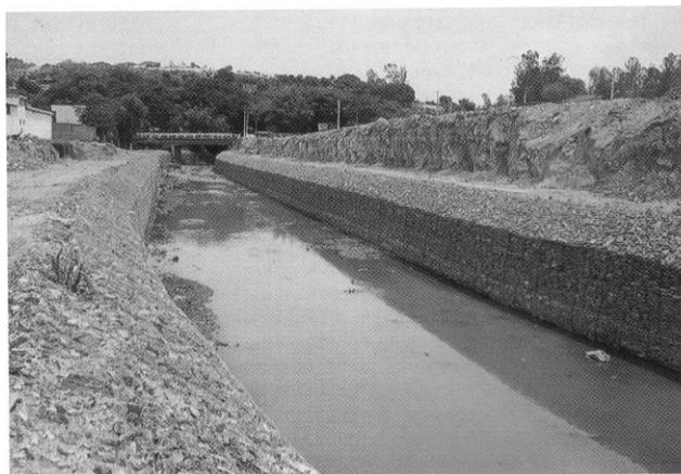
Figura 4.22 Control de cauces por medio de gaviones
