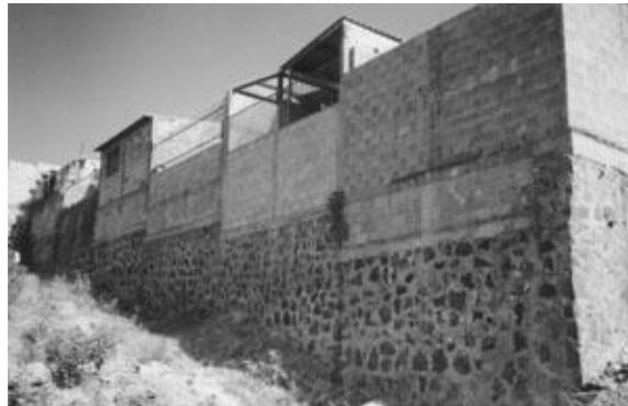
Figura 4.42 Muro de mampostería de piedra en urbanizaciones, con alturas graduales según las terrazas y cuerpos de viviendas
