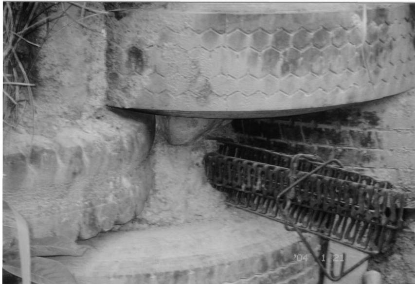
FIGURA No.2.61 Detalle de tensor en muro de llantas
