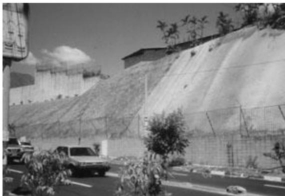
Figura 4.46 Talud estabilizado por medio de concreto lanzado
