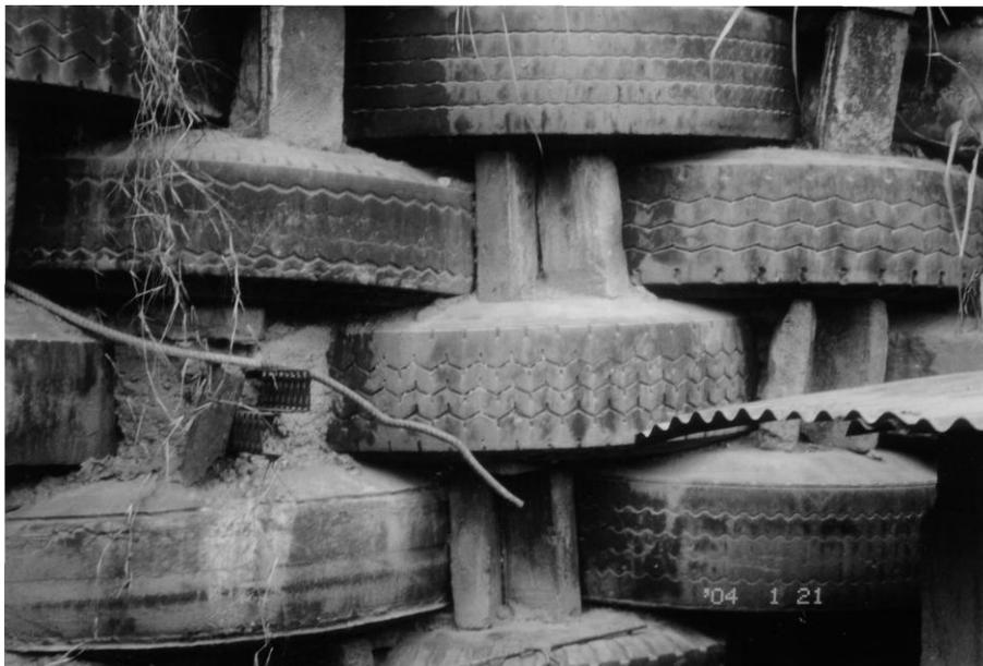
FIGURA No.2.63 Ubicación de ladrillos entre llantas sucesivas
