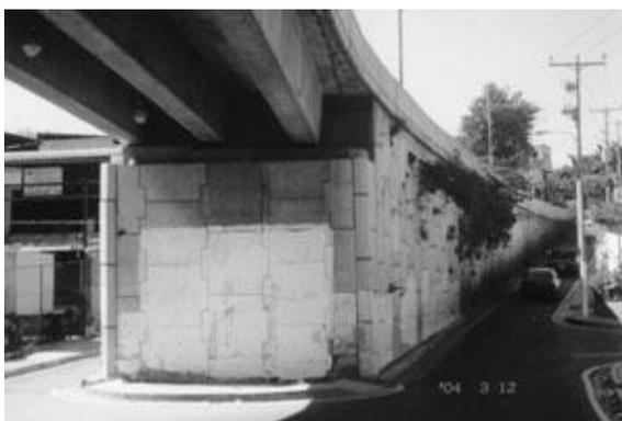
Figura 4.2 Uso de tierra armada en rampa de entrada y salida de pasos a desnivel
