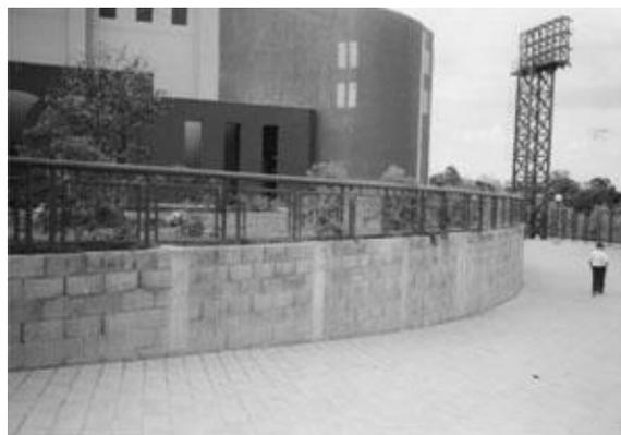
Figura 4.55 Muro de bloques de concreto en desnivel de terreno
