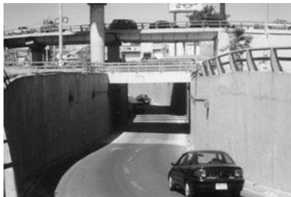
Figura 4.4 Paredes laterales conformadas por muros de retención
