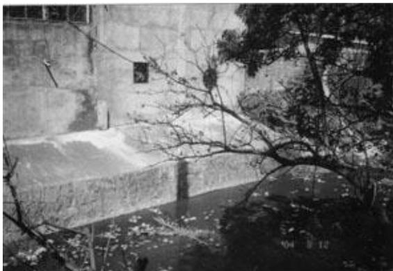
Figura 4.19 Muro de mampostería de piedra para control de cauces
