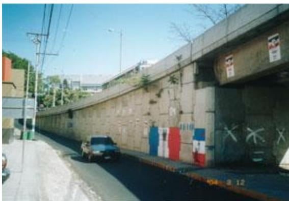
Figura 4.1 Uso de tierra armada en rampa de entrada y salida de pasos a desnivel
