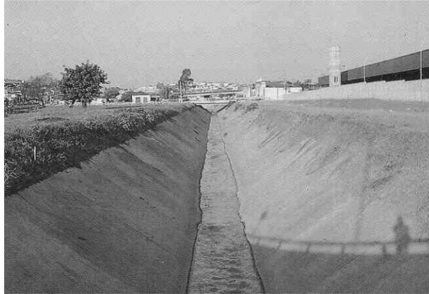
Figura 4.52 Canalización de aguas superficiales por medio de colchones de piedra
