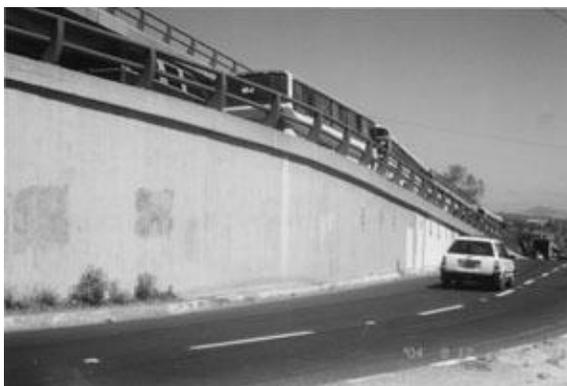
Figura 4.8 Muro en paso a desnivel con acabado simple de repello
