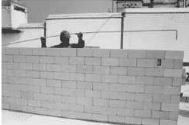
FIGURA No.2.38 Colocación de refuerzo horizontal
