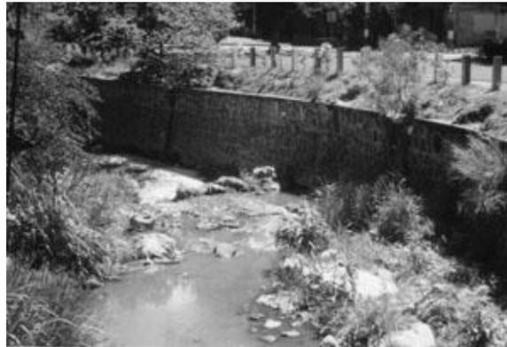
Figura 4.21 Muro de mampostería de piedra para control de cauces
