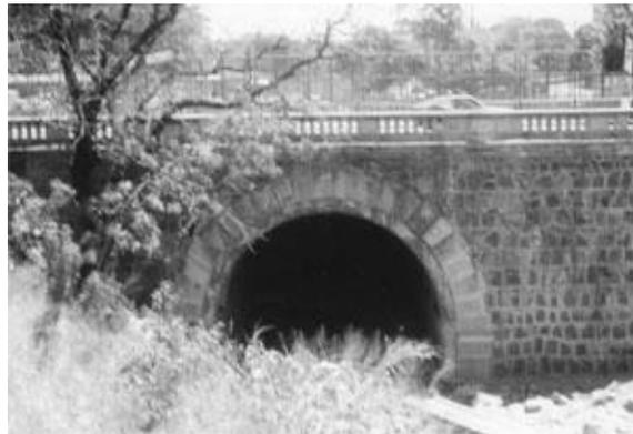
Figura 4.9 Muro de mampostería de piedra en túnel abovedado
