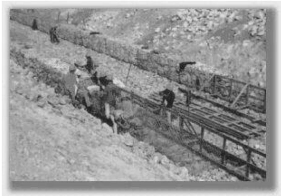
FIGURA No.2.51 Encofrado para Gaviones
