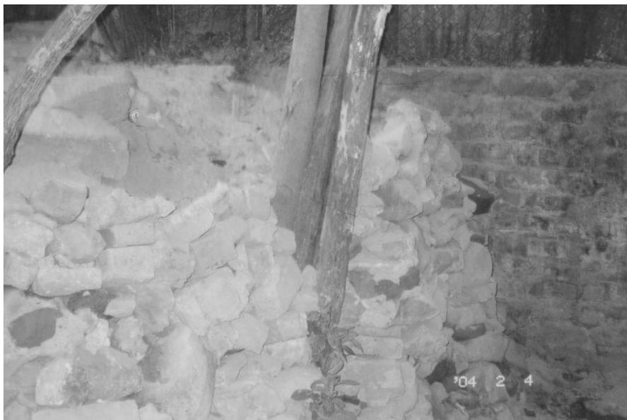
FIGURA No.2.56 Muro de bloques sobrepuestos
