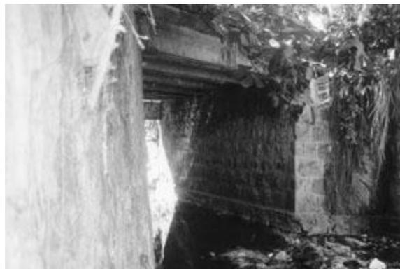
Figura 4.50 Muro de mampostería de piedra en base de puente
