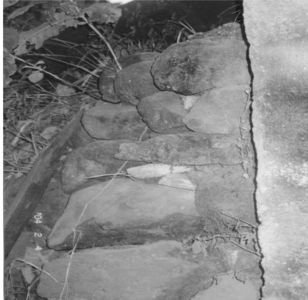
FIGURA No.2.58 Muro de bloques sobrepuestos
