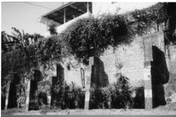
Figura 4.41 Muro de bloques con contrafuertes en vivienda
