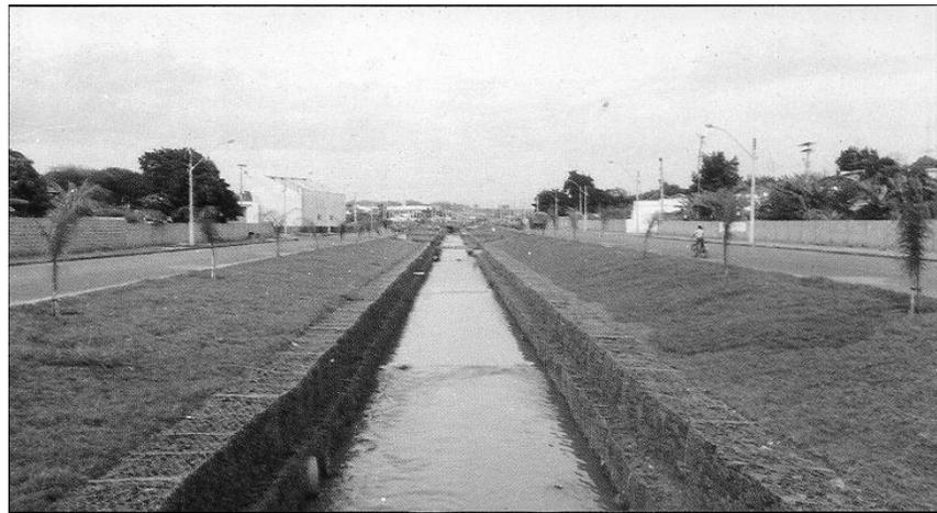
Figura 4.53 Gaviones utilizados para canalización de aguas superficiales
