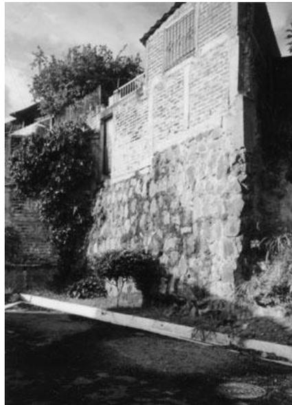
Figura 4.36 Muro de mampostería de piedra para apoyo de vivienda
