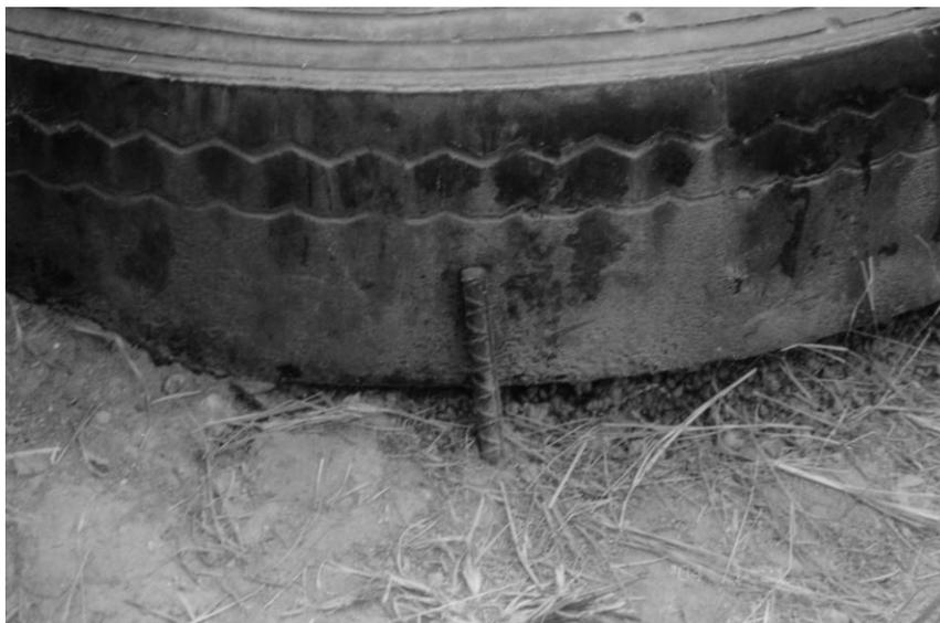
FIGURA No. 2.62 Colocación de refuerzo vertical en llantas
