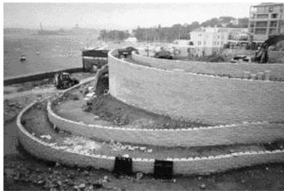
Figura 4.58 Muro de bloques de concreto reforzado
