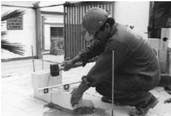
FIGURA No. 2.35 Colocación de la primera hilada.
