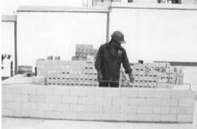
FIGURA No.2.34 Revisión de nivel de hiladas
