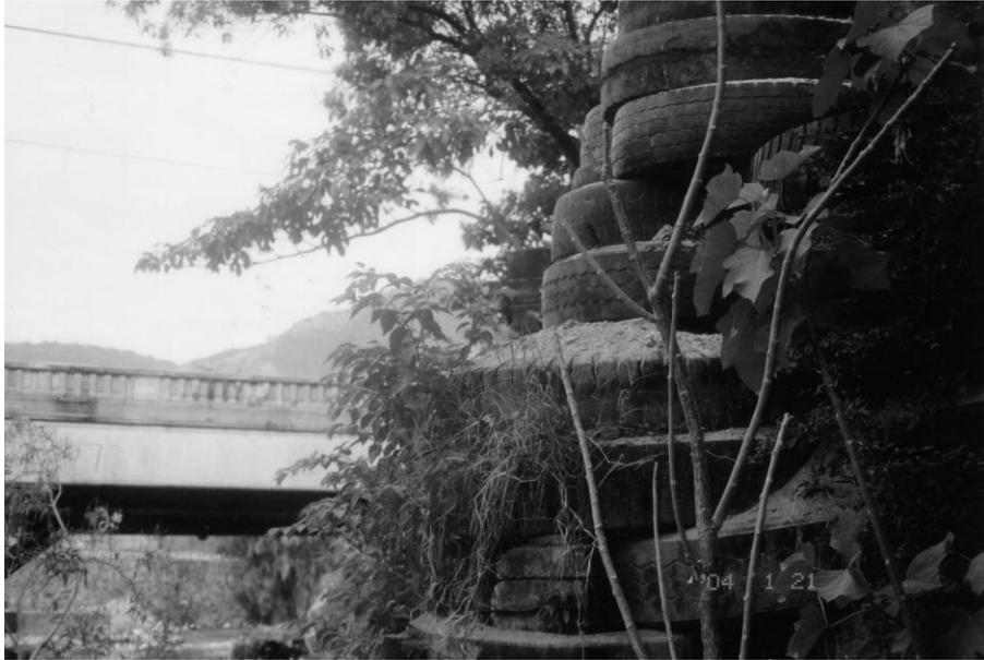
FIGURA No.2.60 Muro de llantas entramadas
