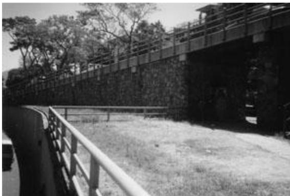
Figura 4.7 Muro en paso a desnivel con acabado de laja
