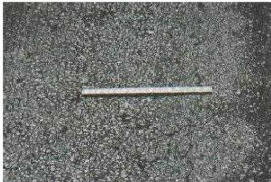
Desprendimiento de agregados de baja severidad
