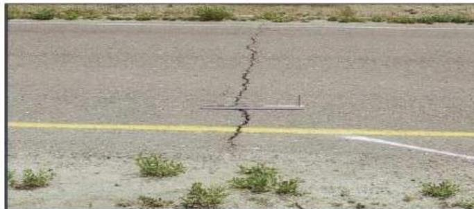
Fisura Transversal, atraviesa toda la sección de la carretera
