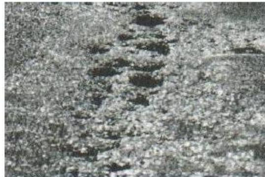
Desprendimiento de agregados de alta severidad.
