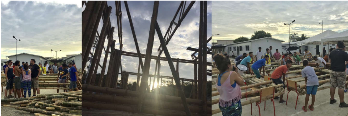
Figura 5 Proceso de montaje y armado del módulo.
