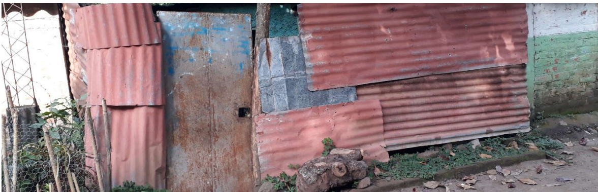
Fotografía 5 Condiciones de Fachadas
