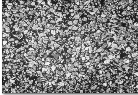
Imagen 2. 15. El agregado pulido no tiene niveles de severidad definidos.
