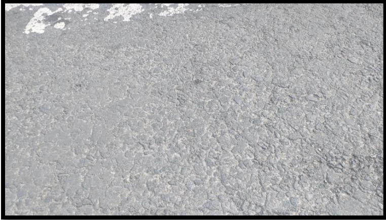
Intemperismo, Nivel de severidad: M
