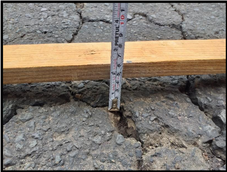
Depresión, Nivel de severidad: M
