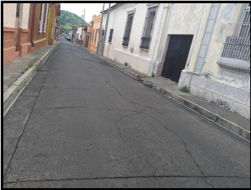
Losa dividida, Nivel de severidad: H
