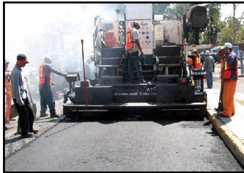
Fig. 43 Colocación de la capa de repavimentación.
