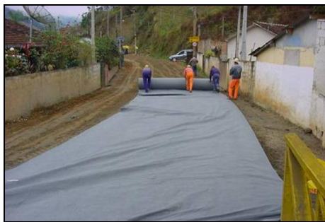
Fig. 39 Procedimiento de colocación del geotextil.
