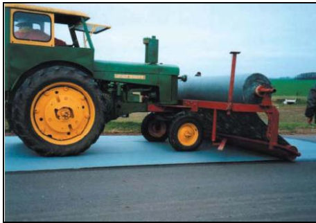
Fig. 74 Equipo mecánico adaptado a tractor para la instalación del geotextil.
