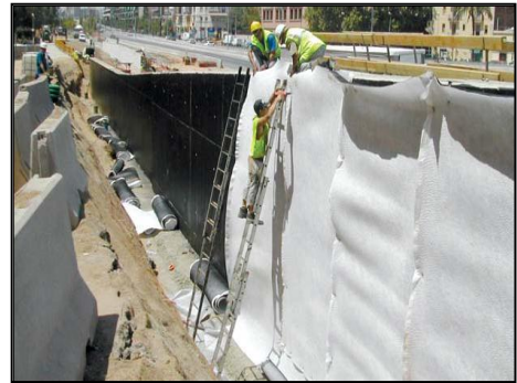
Fig. 9 Aplicación de georedes en paso a nivel
