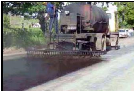
Fig. 42 Aplicación de la capa de ligante asfáltico
