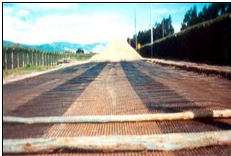
Fig. 41 Geomalla colocada sobre el terreno.
