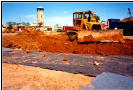
Fig. 40 Colocación de material de relleno sobre geotextil.
