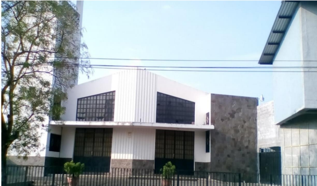
Imagen 26: Fachada Parroquia San Martin de Porres, 2019.
