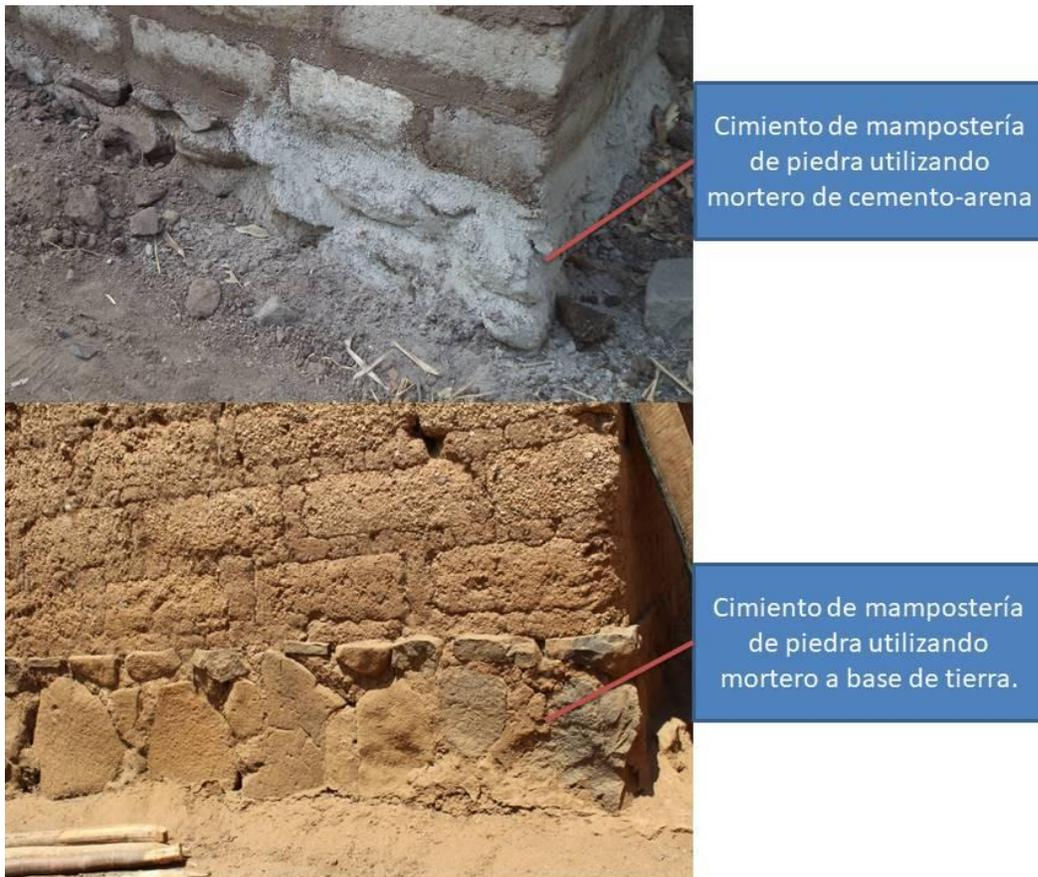
**Ilustración 34. Cimiento con mortero de tierra, y Cemento.**
