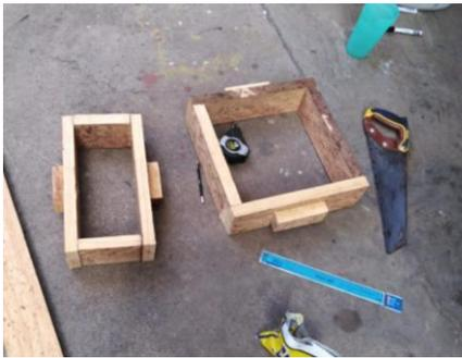
**Ilustración 27. Moldes para Adobe Sismo Resistente.**
