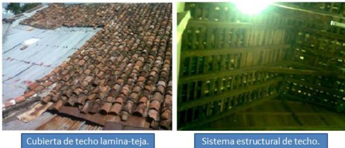
Ilustración 48. Tipos de cubierta de techos en viviendas de adobe.
