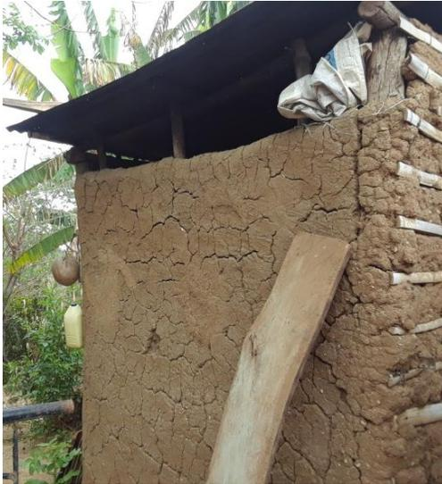
**Ilustración 41. Revestimiento de pared con mortero de tierra.**
