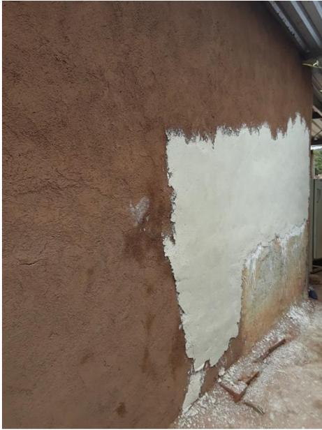
Ilustración 42. Revestimiento de pared con mortero de cal.
