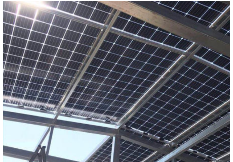
Figura 3.51: Ejemplo de un módulo fotovoltaico bifacial.
