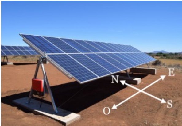
Figura 3.69: Seguidor solar horizontal 1 eje. movimiento Norte-Sur.
