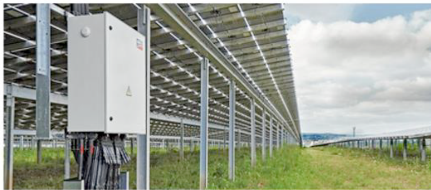
Figura 4.36: Representación de una caja de conexiones de un generador fotovoltaico. [53]
