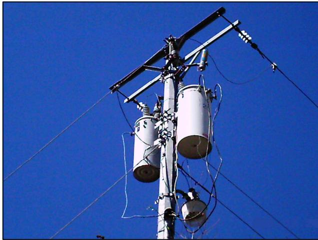
Figura 3.3 Subestación elevadora de la minicentral “La Chácara”.
