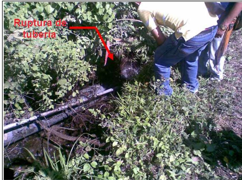
Figura 3.4 Tubería de presión con pérdidas por ruptura.
