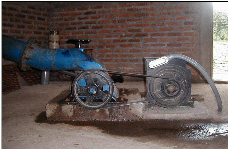
Figura 3.2. Sistema generador – turbina de la casa de máquinas.
