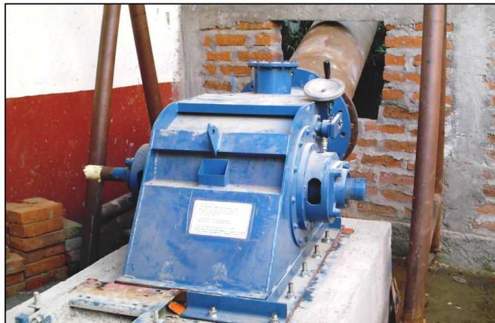
Figura 3.14 Turbina Michell – Banki instalada en la minicentral La Chácara
