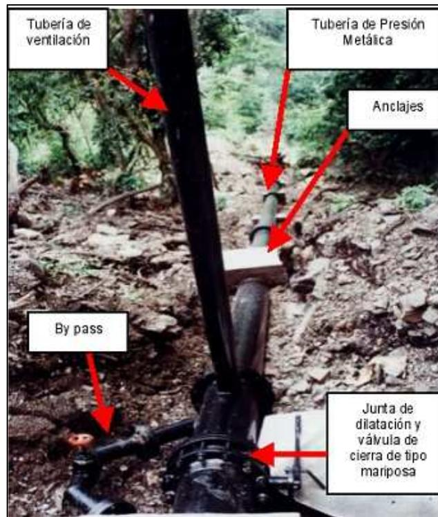
Figura 2.27 Tubería de presión.
