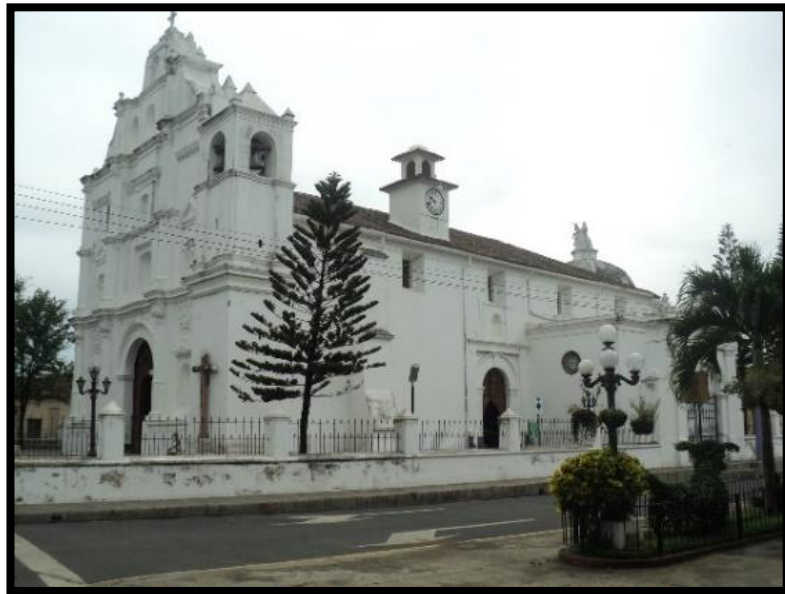
Fotografía 6: Iglesia Santiago Apóstol
