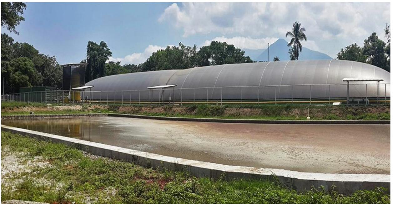
*Figura 69.* Diseño final del biodigestor de laguna carpada. Fuente: Novatio, Colombia 2019.
