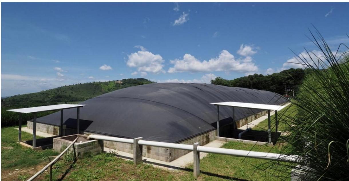
*Figura 67.* Diseño de carpado de membrana de la laguna. Fuente: Novatio, Colombia 2019.
