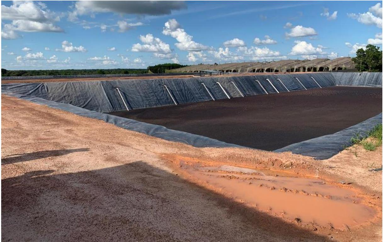
*Figura 66.* Preparación de laguna en pila de desechos. Fuente: Novatio, Colombia 2019.
