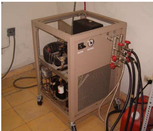
Figura 4.1.1.2.1: Equipo encargado de suministrar agua al sistema de enfriamiento del PW1730/00.
