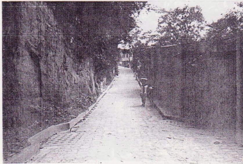
Fotografía 3. Pasaje Celestino Norte, las características de pendiente fuerte y finaliza en la quebrada río Chiquito y que con una obra de paso conecta con la colonia Veracruz, acceso vehicular adoquinado para colonia Veracruz, con aceras y cunetas definidas.
