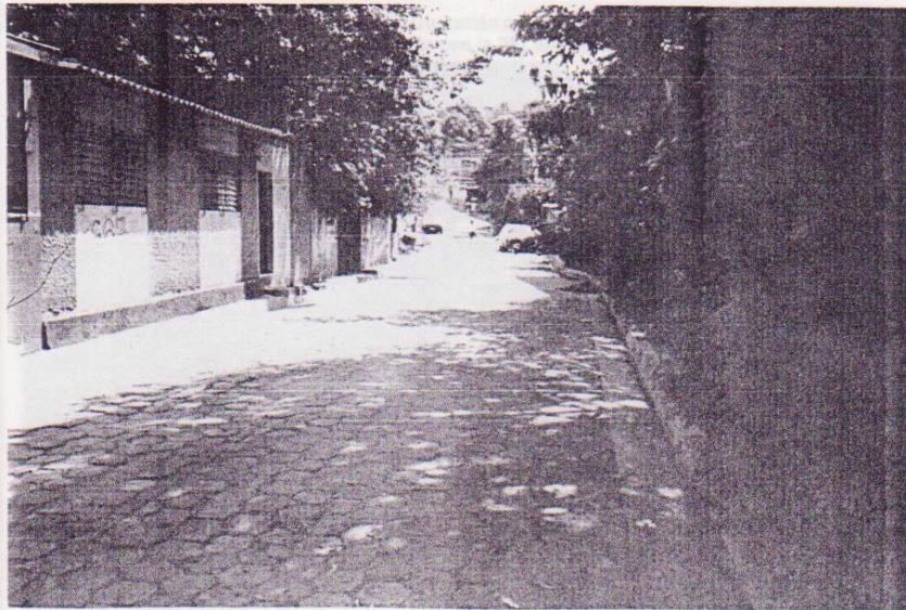
fotografía 1. 3ª. Calle Oriente que accesa a las colonias Chaín, Cuscatlan y Primavera, con superficie de rodaje adoquinada y sistema de drenaje superficial(cordón, cuneta).
