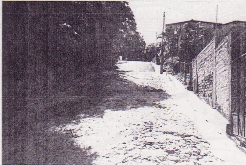
Fotografías 10 y 11. Colonia Veracruz, final de la calle principal, empedrada y con drenajes superficiales de Aguas servidas y A.N..
