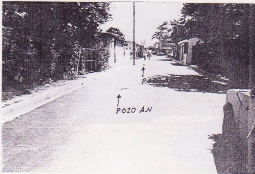
Fotografía 7. Calle Principal Colonia Veracruz, con un ancho de rodaje definido y revestida con mezcla asfáltica.
