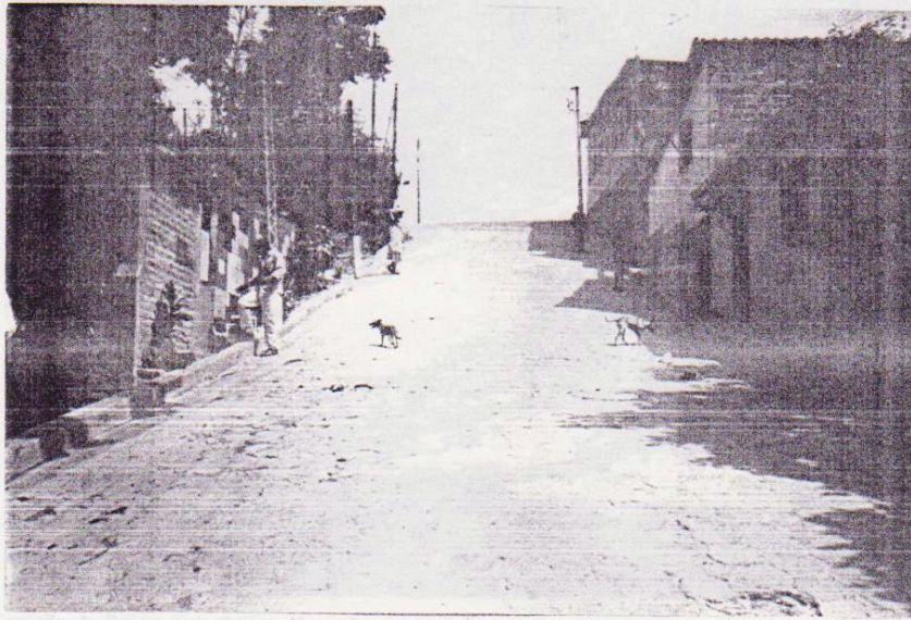
Fotografía 2. Pasaje Celestino de la colonia Cuscatlán con pendiente fuerte y con una diferencia de nivel considerable con la 3ª Calle oriente
