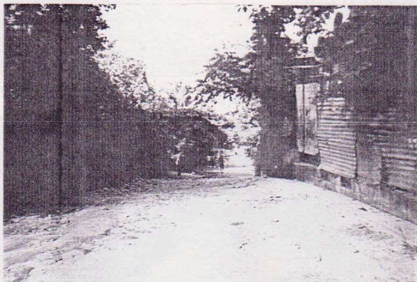
Fotografía 12. Calle Principal, Colonia Rosales (Ruta de Entronque), pasaje con superficie sin revestimiento (calzada sobre tierra), sirve de acceso peatonal y vehicular.
