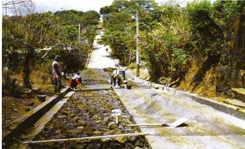
Foto: Empedrado de concreto del Pasaje "K", Col. El Carmen, San Antonio del Monte
