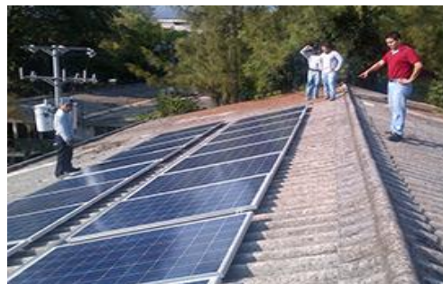
Imagen 8. Instalación de paneles fotovoltaicos en Oficina IICA El Salvador. Fuente: iicaelsalvador.com
