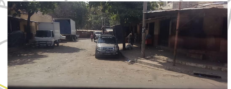
17 Calle Pte. (Vista hacia el Poniente) Sobre ésta se encuentra el acceso principal hacia las instalaciones de Ángeles descalzos, lastimosamente no se encuentra en optimas condiciones ya que su capa asfáltica se encuentra muy deteriorada y sus aceras son ocupadas como bodegas bloqueando el acceso peatonal a las instalaciones. Ésta calle conecta directamente con la Ave. Fray Felipe de Jesus Moraga que es una Vía de Circulacion Mayor.
