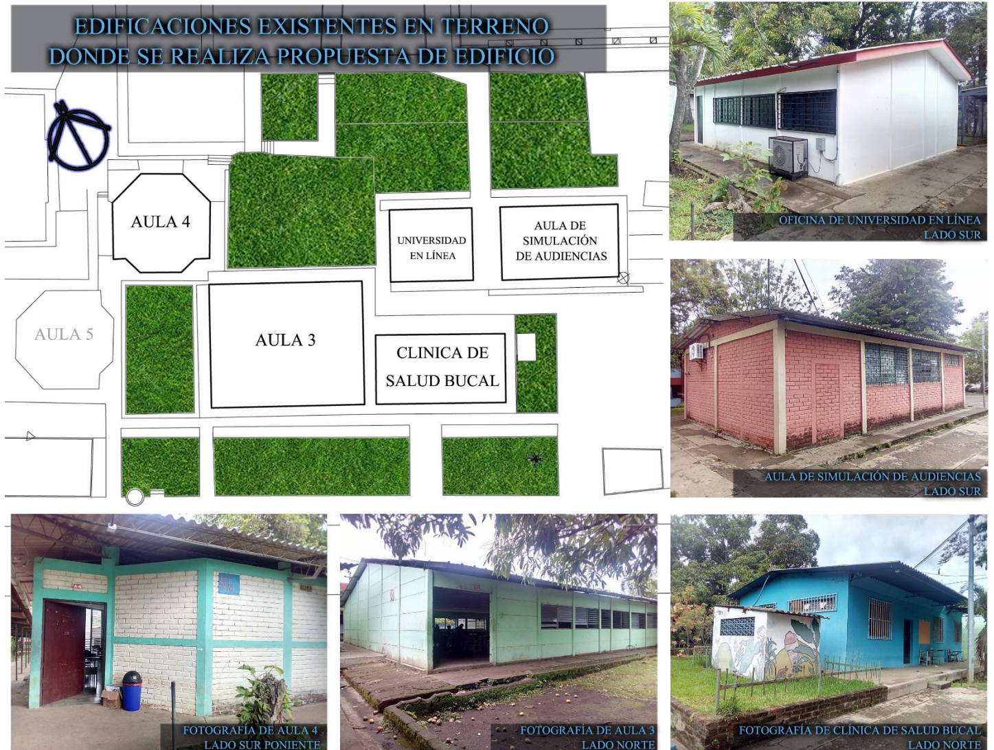
Ilustración 28 Ilustración de edificaciones existentes dentro del terreno a intervenir
