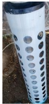
Figura A2 Colocación de filtro en estanques.
