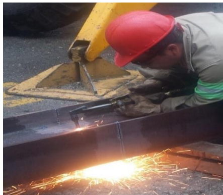
Figura 4.4: Realización de corte con soplete.
