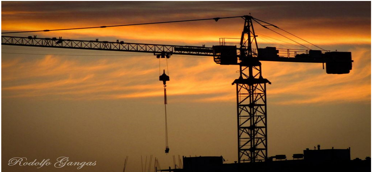
Figura 3.22: Pluma torre grúa.
