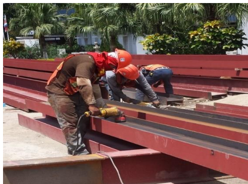
Figura 4.5: Limpieza y cepillado de Estructuras Metálicas.
