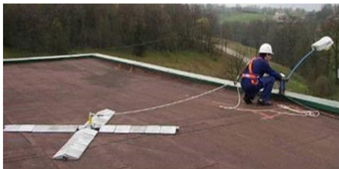
Figura 6.20: Dispositivos de anclaje tipo E.
