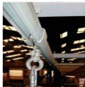
Figura 6.19: Dispositivos de anclaje tipo D.
