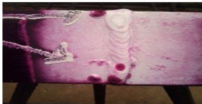
Figura 5.16: Imperfecciones detectadas por líquidos penetrantes.
