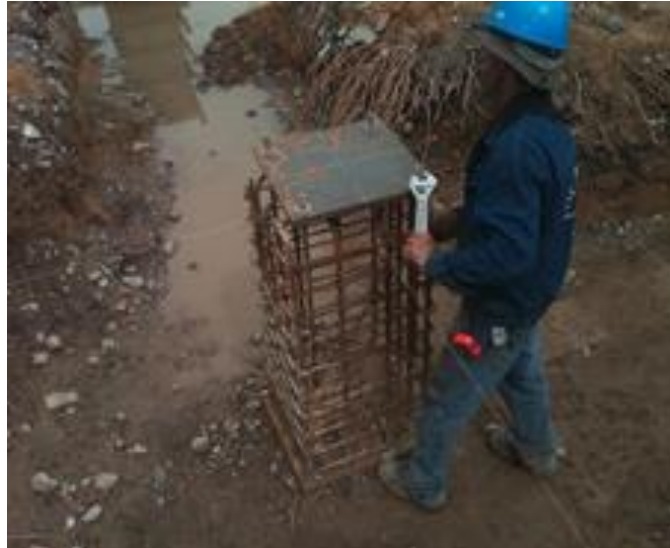
Figura 4.7: Anclaje de Estructuras Metálicas.
