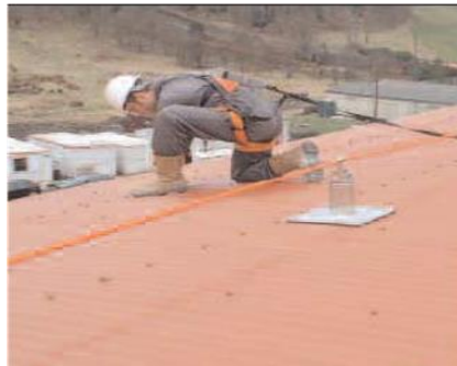
Figura 6.18: Dispositivos de anclaje tipo C.
