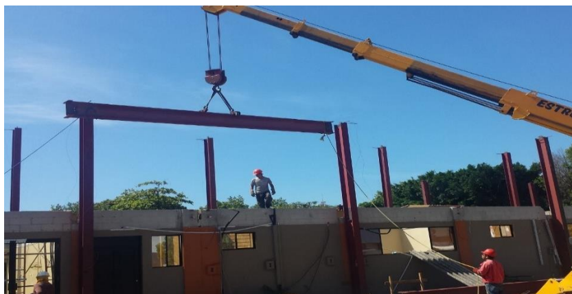
Figura 4.8: Secuencia de montaje.
