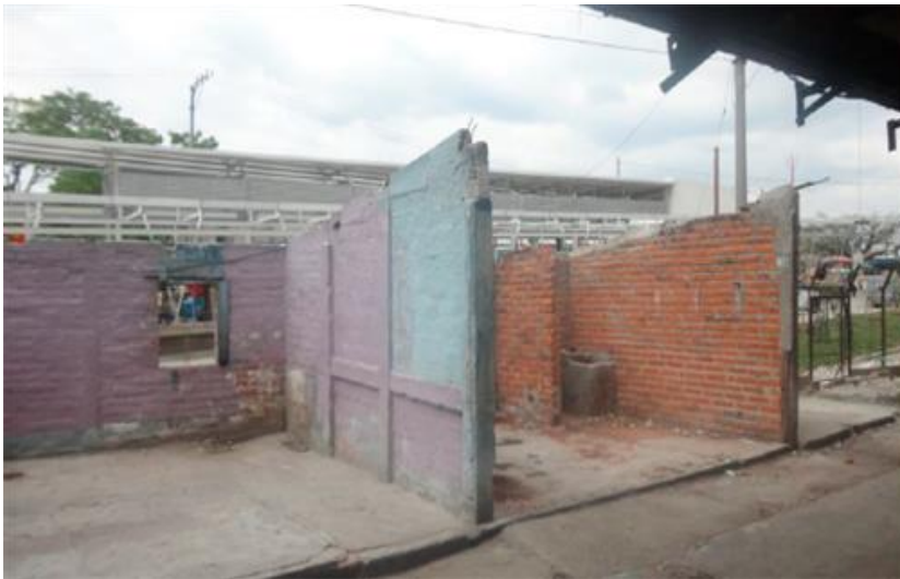
FOTOGRAFIA 01. Infraestructura existente dentro del terreno de la Ex – Terminal de Oriente. Fuente: Alcaldía de San Salvador, 2018.
