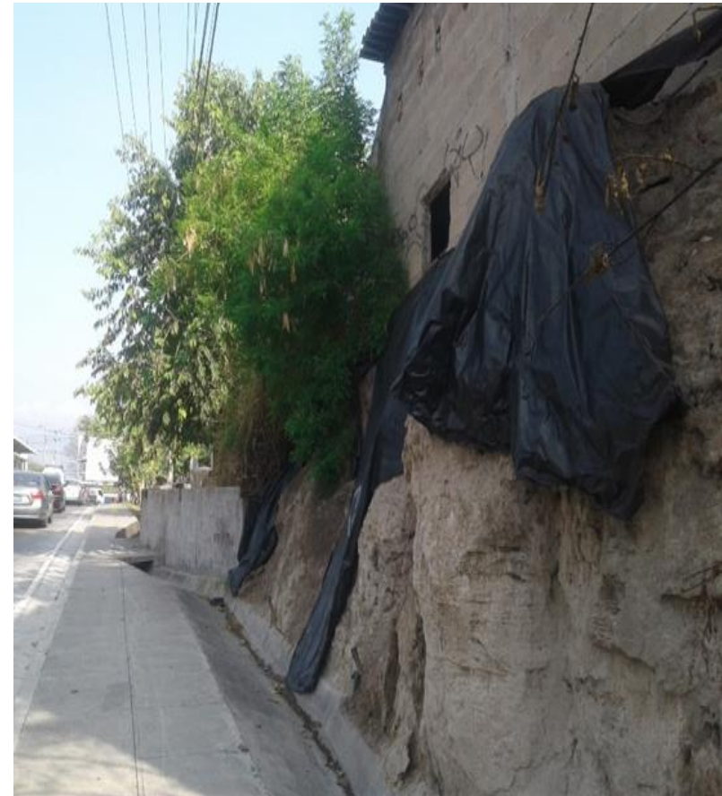
FOTOGRAFIA 06. Taludes sin protección y erosionados al costado sur del terreno. Fuente: Elaboración propia, 2019.
