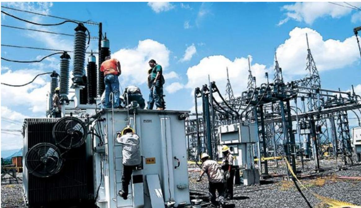
Fig B- 1: Cuadrillas trabajan en el cambio de transformador de potencia dañado por un impacto directo de rayo en la subestación Miraflores
