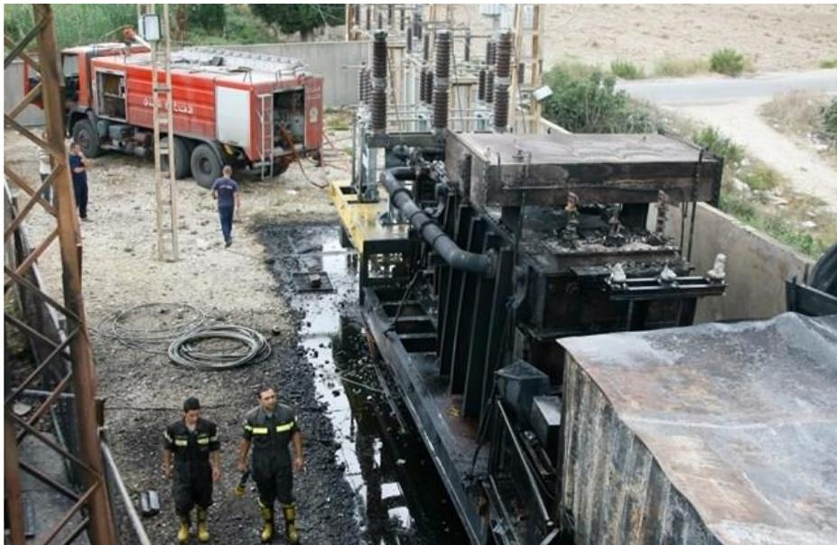
Fig B- 2: Daños ocasionados por el impacto directo de rayo en la subestación ubicada en Tiro, Líbano
