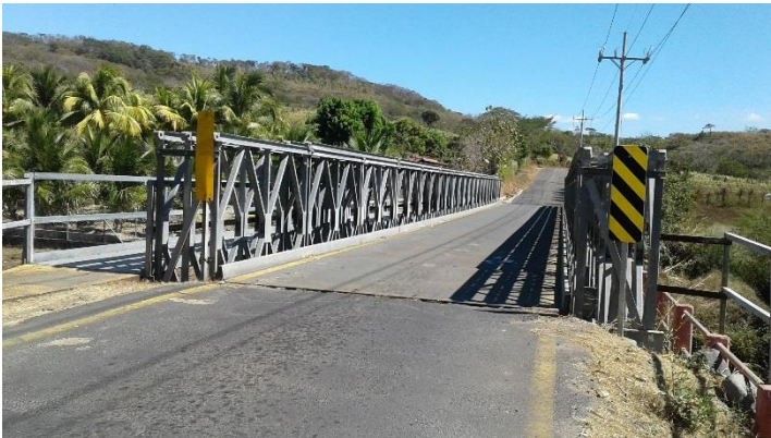
Puente edificado después que el anterior colapsara por el desbordamiento del río Sucio, noviembre 2011.
