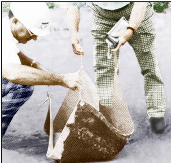
Fig. 2.37 Pesado de cemento recogido en una lona de 1 yd<sup>2</sup> para verificar la cantidad de cemento esparcido.
