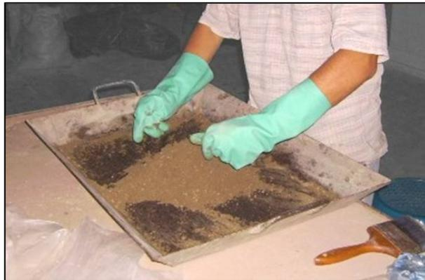
**Fig. 3. 20. Elaboración manual de la mezcla de suelo cemento.**
