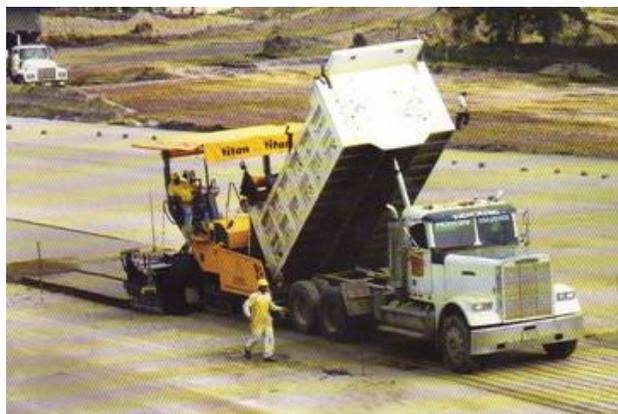
**Fig 2.31** Colocación de suelo cemento con Fínisher.
