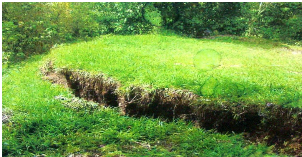
Foto 3.3.7 Elevación de terrenos por perforaciones excesiva en el suelo
