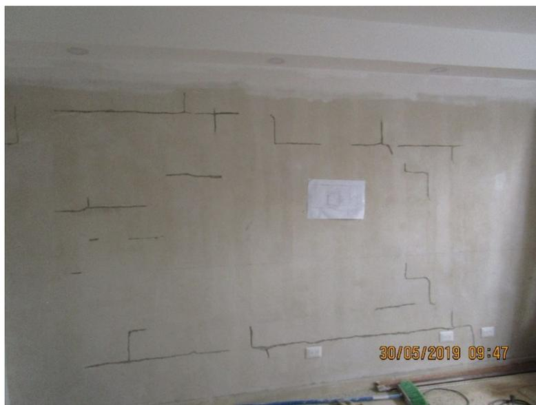
*Fotografía No 3-4: Se muestra el ensanchamiento de las fisuras de la pared oeste*
