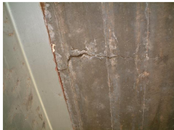
Fisuras bajo la losa
