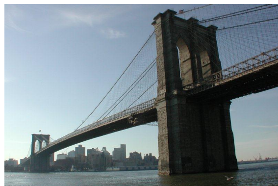
Fig. 2.5. Imagen del puente de Brooklyn una de las más grandes obras construidas con acero. Ubicado en New York EE.UU. Puente colgante con 487m de luz central.
