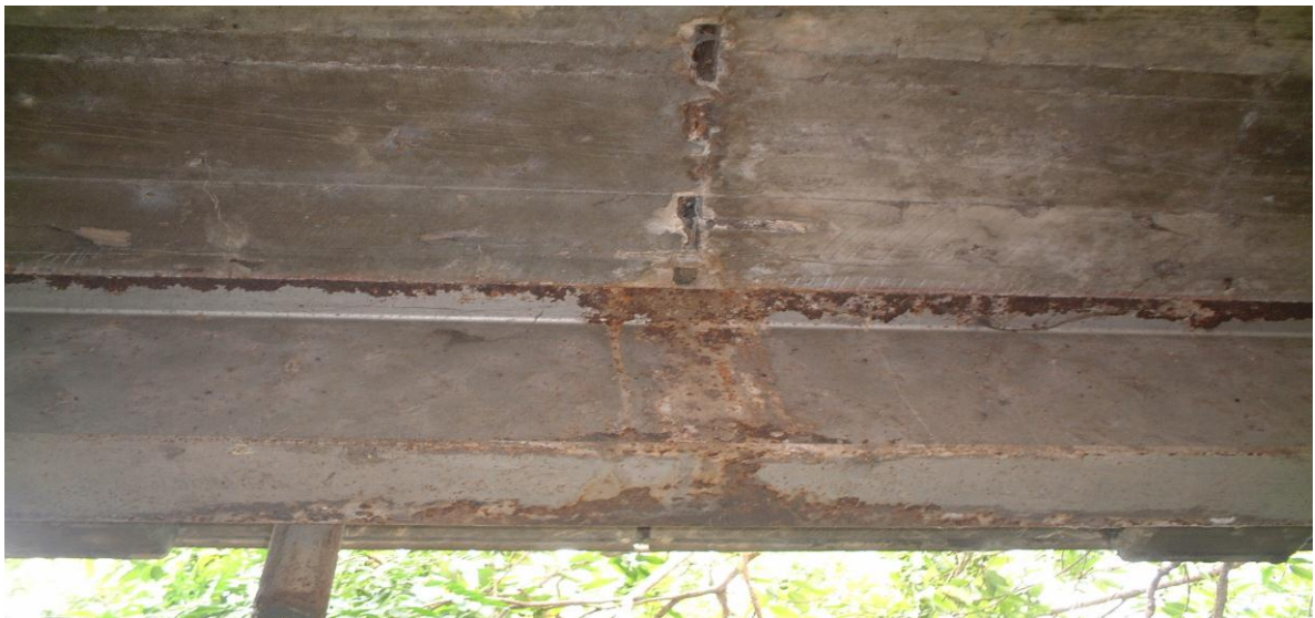
b) Viga de acero
