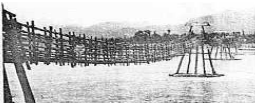
Fig. 2.2. Puente de Madera 9 .
