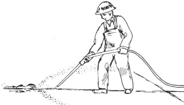
Fig. 4.59. Limpieza de juntas.
