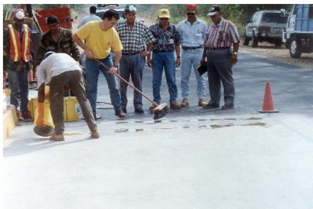
Fig. 4.16. Aplicación de la resina de baja viscosidad en calzada de concreto, por medio de escobillones.
