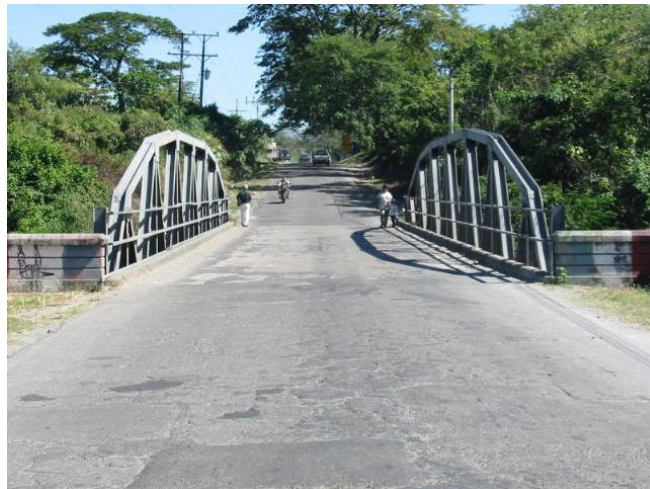
Fig. 3.7. Puente de arazón lateral ubicado sobre el río Comalapa, departamento de La Paz.
