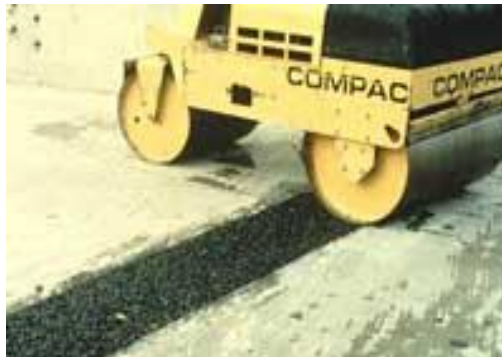
Fig. 4.62. Compactado de juntas asfálticas.
