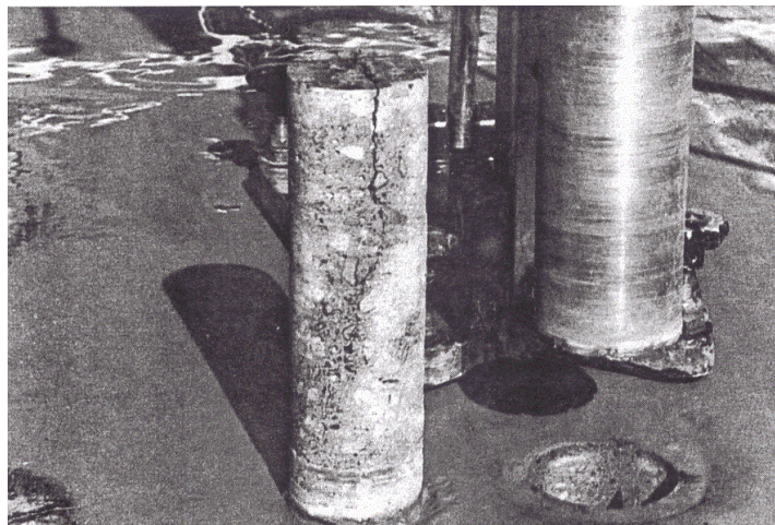
Fig. 4.10. Extracción de núcleos en una losa delgada.
