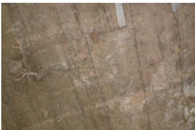
Fisuras bajo la losa
