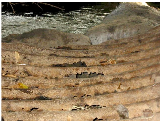
Presencia de corrosión, pérdida de la capa de pintura y de sección
