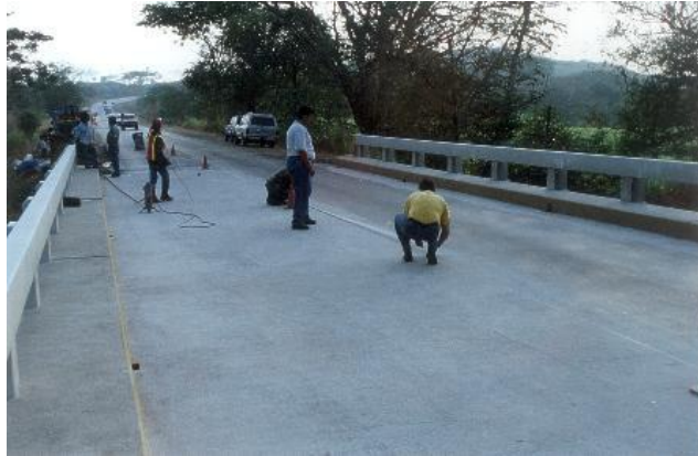
Fig. 4.13. Delimitación del área a trabajar en un puente.
