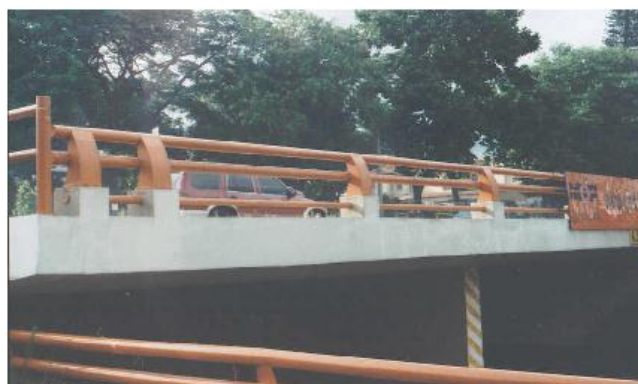
Barandal metálico con bordillos de concreto reforzado (Barandal tipo ASSHTO)
