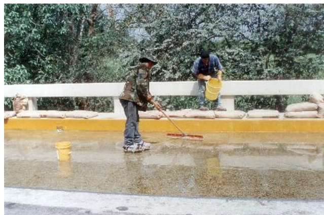
Fig. 4.17. Colocación de resina epóxica de alta viscosidad en calzada de concreto.
