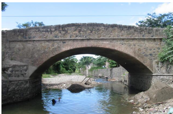
Fotografía: Puente de Mampostería
