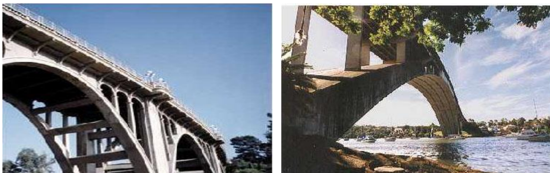
Fig. 2.6. Puentes de concreto reforzado.
