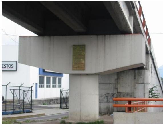
Fig. 3.40. Fotografía de Pila tipo cabeza de martillo, sobre Paso 3º nivel Blvd. Venezuela (Int. 49º Av. Sur)
