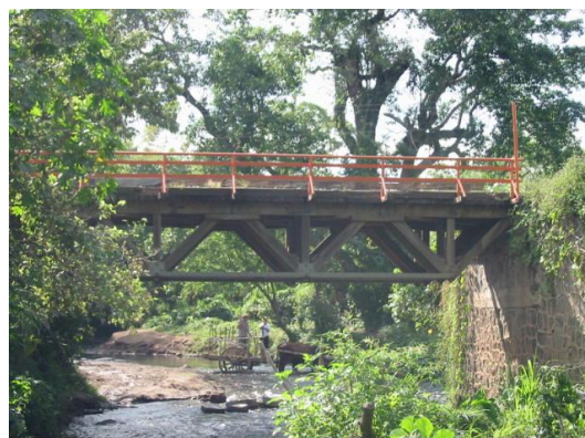
Fotografía: Puente de Madera.
