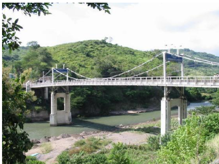
Fig. 3.9. Puente Colgante “El Jobo” sobre el río paz, ubicado entre Ahuachapán – Frontera Las Chinamas; departamento de Chalatenango.
