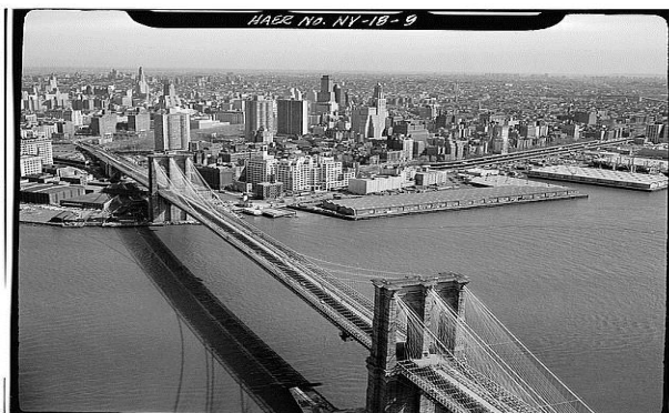
Fig. 2.5. Imagen del puente de Brooklyn una de las más grandes obras construidas con acero. Ubicado en New York EE.UU. Puente colgante con 487m de luz central.
