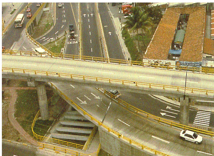
Fig. 2.7. Paso a desnivel de vigas de concreto preesforzado, Hermano Lejano.
