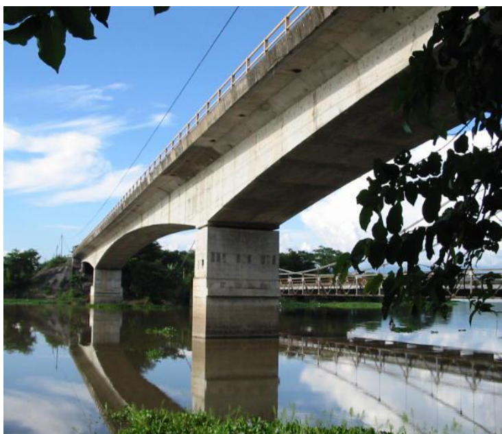
Fig. 3.1. Puente Colima sobre río Lempa, Límite Departamental San Salvador – Citalá (CA04N) Chalatenango.
