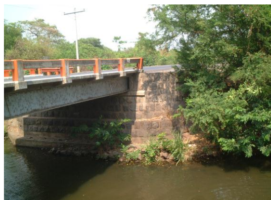
Barandales y pasamanos de concreto
