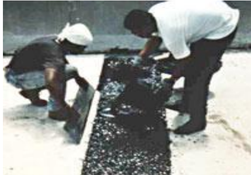
Fig. 4.61. Sellado de juntas.
