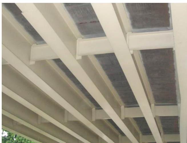
Fig. 3.12. Diafragmas transversales en vigas de acero.
