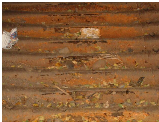
Presencia de corrosión, pérdida de la capa de pintura y de sección
