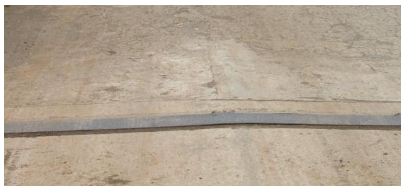
Junta Cerrada, Tipo Placa Deslizante.
