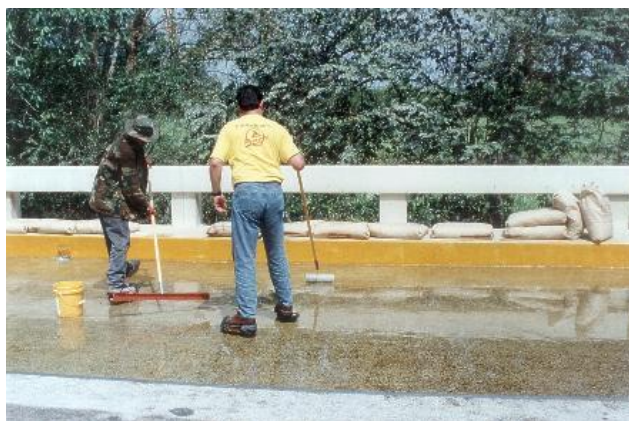
Fig. 4.18. Método de desairación de la resina epóxica en calzada de concreto.
