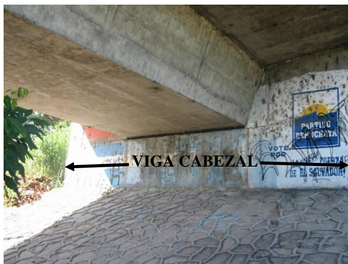
Fig. 3.32. Ilustración de una Viga de Cabezal.
