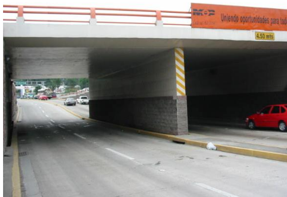
Fig. 3.39. Fotografía de Pila tipo pared, Blvd. Los Héroes (Int. Alameda Juan Pablo II).
