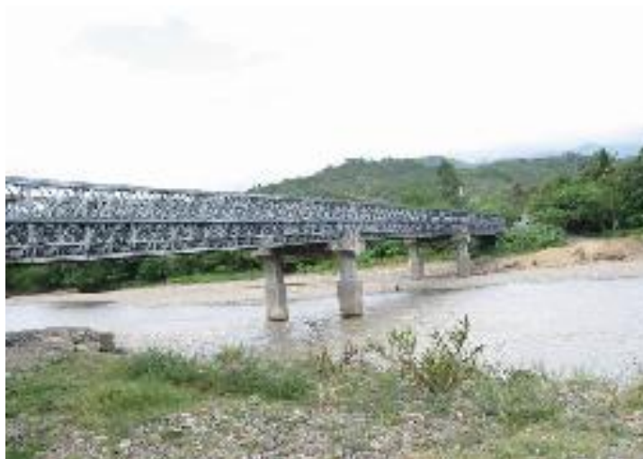
Fig. 3.10. Puente Tipo Bailey, sobre río Lempa; departamento de Chalatenango.
