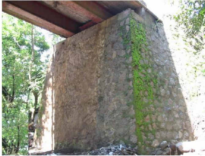
Fig. 3.30. Ilustración de una pantalla de estribo.
