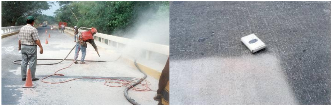
a) Aplicando Chorro de Arena a superficie de concreto.
