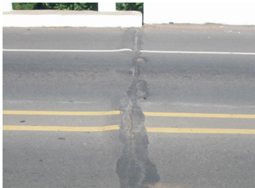
Afloramiento y Degradación del Sello
