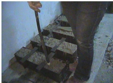
**5. Vibrado del concreto en moldes.**
