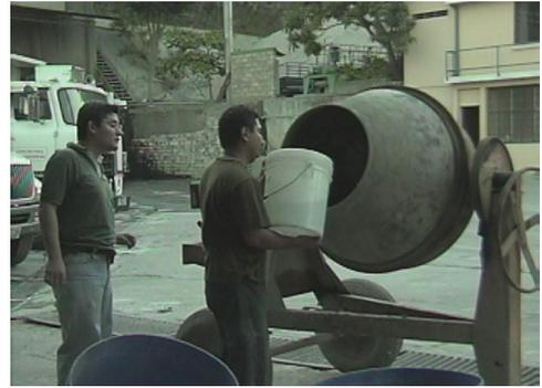
**2. Colocación del agregado en la tolva.**
