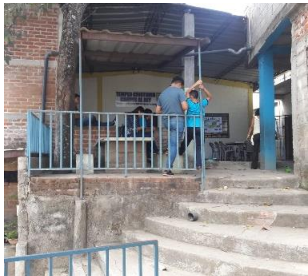
Imagen 3. Estado actual del patio 3 y patio 4. Elaboración propia.
