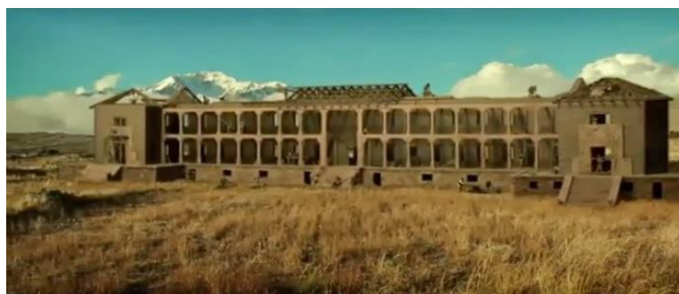
Ilustración 16: Escuela Ayllu de Warisata, Bolivia. En construcción 1919.
