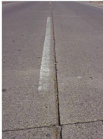
Fig. 45. Daño del sello de la junta longitudinal con severidad alta
