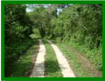
Vista parcial de una calle a base de cinteado
