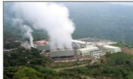
VISTA AEREA DEL CAMPO GEOTERMICO DE BERLIN
