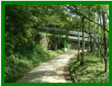
Vista parcial de una calle a base de concreto
