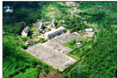
VISTA AEREA DEL CAMPO GEOTERMICO DE AHUACHAPAN
