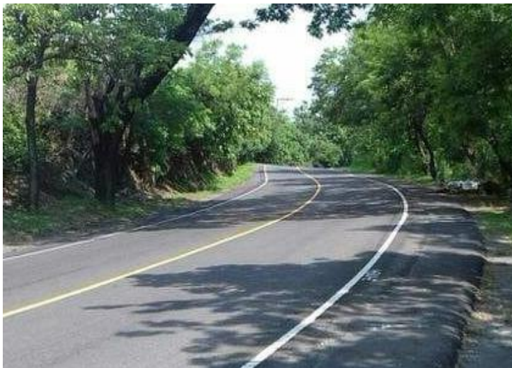
Figura 3.6: Pavimento Flexible CA02E Dv. Aeropuerto El Salvador – Zacatecoluca.
