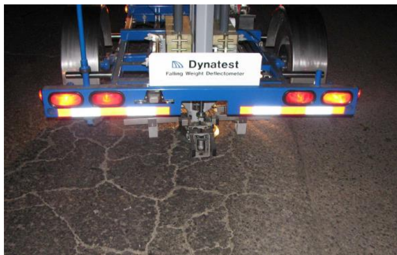
Figura 3.10: Medición de deflexiones en sentido Sonsonate - Puerto Acajutla.
