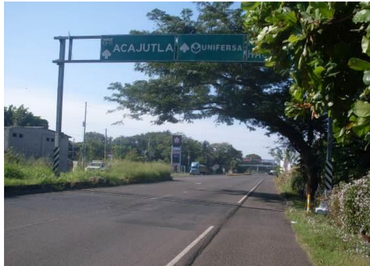
Figura 3.4: Pavimento Flexible Tramo III CA12S Puerto Acajutla.
