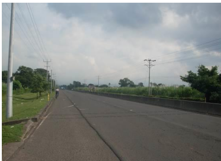
Figura 3.3: Pavimento Flexible Tramo II CA12S Desvió La Libertad.
