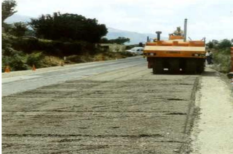
**FIG. 2.36 Rodillo de Neumático Autopropulsado**
