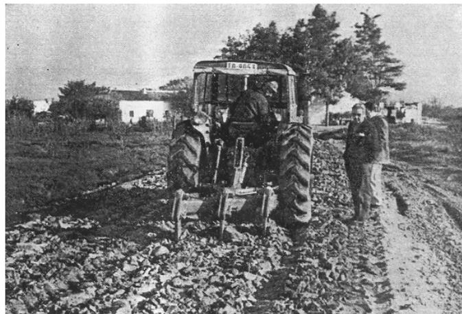
**FIG. 2.34 Escarificado del Suelo Utilizando Equipo Agrícola**
