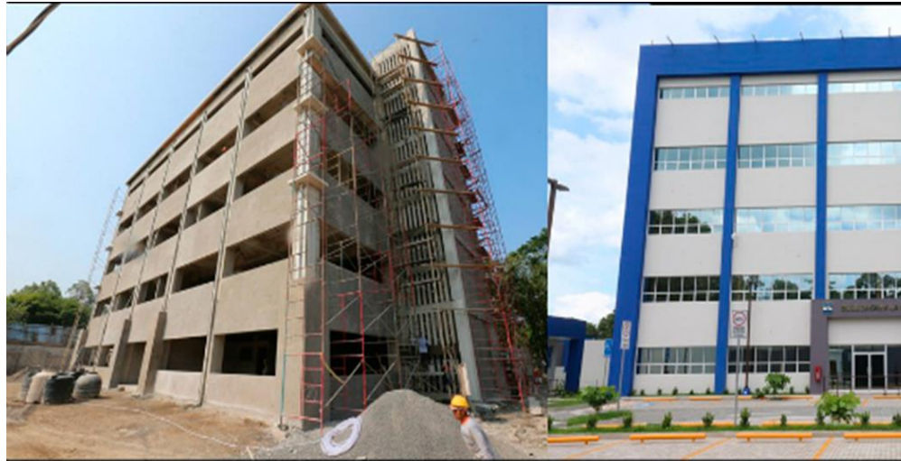
Ilustración 10: Etapa de construcción del nuevo edificio de la delegación del departamento de la Paz.
