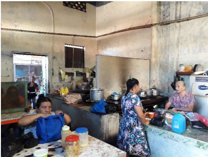
FOTOGRAFÍA 17: Zona de Cocinas y comedores. El mal mantenimiento de los puestos y mobiliario además no cuenta con red de sistema de seguridad. Fuente propia
