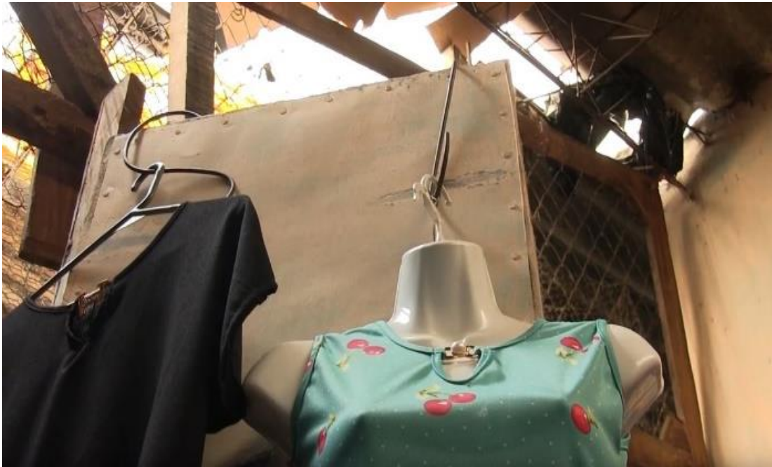
FOTOGRAFIA 3: La mayor parte de infraestructura del inmueble se encuentra en mal estado por la falta de mantenimiento adecuado. Fuente propia.
