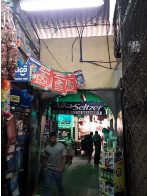
FOTOGRAFÍA 15: Zona de Cereales y otros productos con invasión de pasillos con productos y así también como el mal mantenimiento de infraestructura. Fuente: propia
