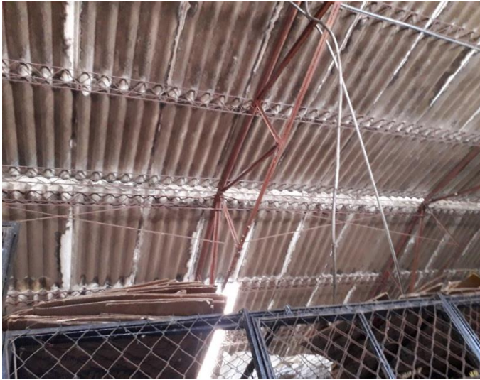
FOTOGRAFÍA 23: Mal estado de infraestructura de techos de tipo fibrocemento agrietadas y quebradas en algunos casos reparadas con repello de cemento. Fuente: Propia.
