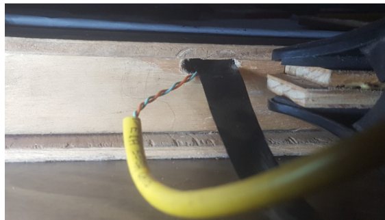
Figura 4.152: Introducir el cable de la cámara por C4 y sacarlo por B5. Fuente: Elaboración propia.
