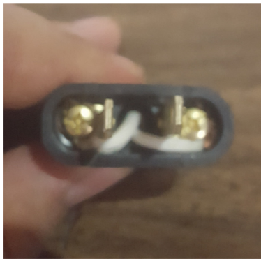
Figura 4.127: Atornillar cable duplex al enchufe. Fuente: Elaboración propia.
