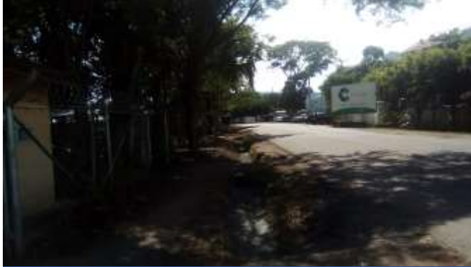
Vista de cuneta y acera existente en dirección al cantón La Cabaña
