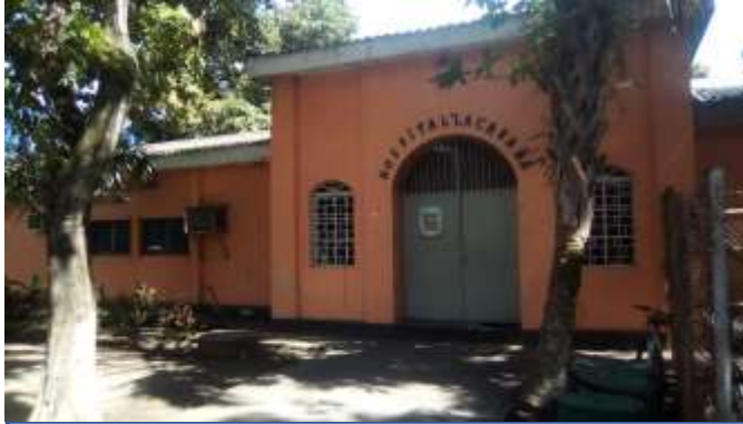
Fachada de infraestructura existente, clínica empresarial del ISSS correspondiente a Ingenio La Cabaña
