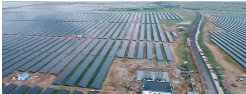
Ilustración 16: Pavagada Solar Park. 2.050 MW. India
