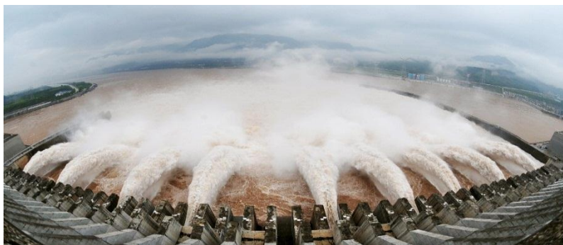
Ilustración 6: Central hidroeléctrica de las tres Gargantas, china
