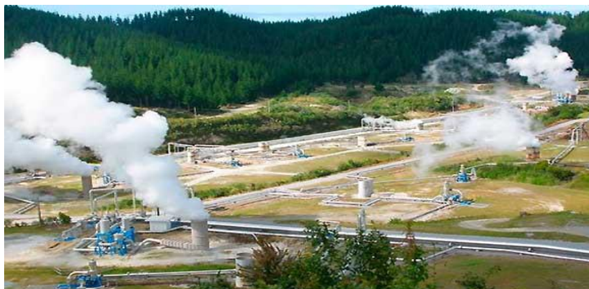
Ilustración 14: Complejo Geotérmico Cerro Prieto – México
