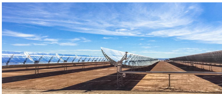
Ilustración 20: Planta termosolar Noor I-Ouarzazate. 160 MW. Marruecos
