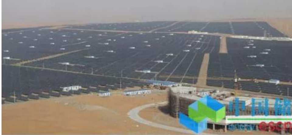
Ilustración 17: Parque Solar del Desierto de Tengger. 1.500MW. China
