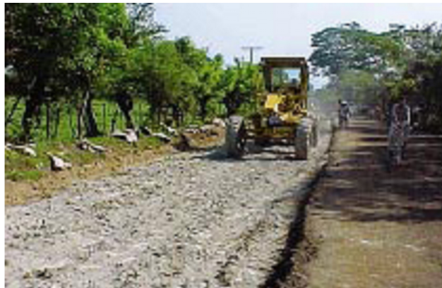
FIG. 4.9. Mezclado del suelo cemento con motoniveladora en campo en una carretera.
