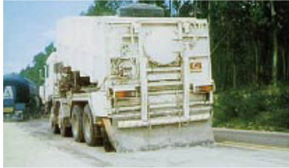
FIG. 4.7. Distribuidor automático de cemento en polvo en una capa de base de una carretera.
