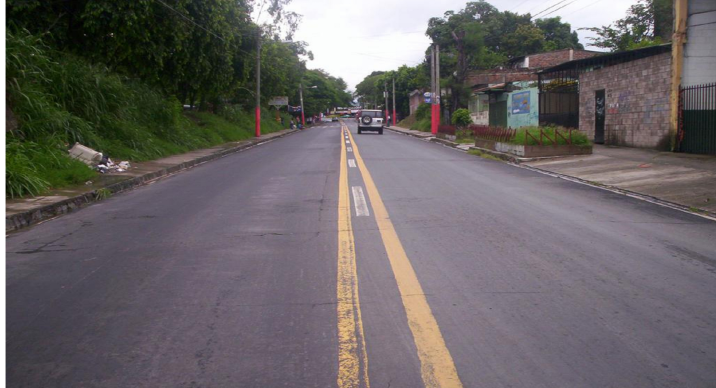
FIG. 3.11. Pavimento con superficie de concreto asfáltico. Col. La Cruz, San Bartolomé Perulapía, Cuscatlán.
