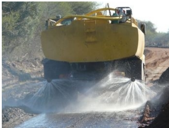
FIG. 4.3. Humectación del material de subrasante cuando está muy seco.
