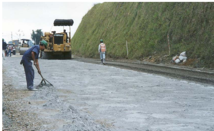
FIG. 2.30 Aplicación de cemento en la estabilización de bases para pavimentos.
