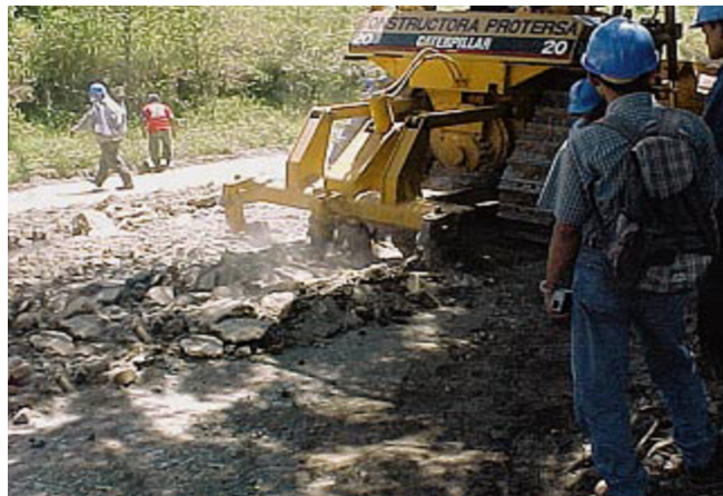
FIG. 4.2. Escarificación de la superficie de la subrasante.
