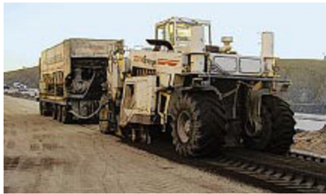
FIG. 4.10. Mezclado del suelo-cemento con equipo rotativo, mezclador-escarificador en una carretera.
