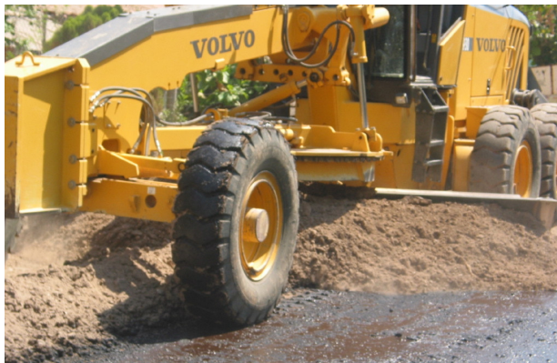
FIG. 5.15. Mezclado con motoniveladora del suelo con emulsión asfáltica en un tramo de carretera.
