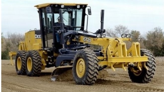
FIG. 4.4. Aireación del material de subrasante cuando éste tiene exceso de humedad.
