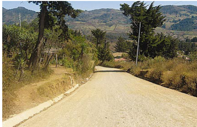
FIG. 3.9. Pavimento con superficie de tierra, San Juan los Planes, Santa Tecla, San Salvador.
