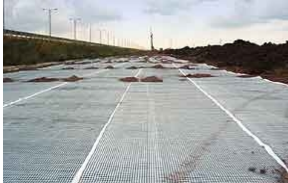
FIG. 2.37 Colocación de geosintéticos en la estabilización de suelos.
