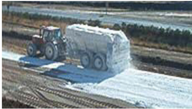
FIG. 4.12. Distribuidor automático de cal en polvo en una capa de base en una carretera.
