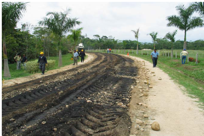
FIG. 2.31 Aplicación de una emulsión asfáltica en la estabilización de bases para pavimento.
