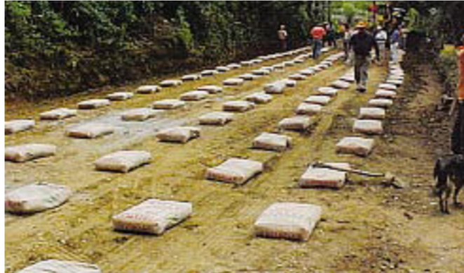
FIG. 4.6. Colocación de bolsas de cemento sobre el material de subrasante para su dosificación y posterior mezclado.
