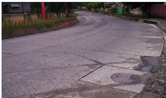
FIG. 3.12. Pavimento con superficie de concreto hidráulico, Col. Santa Lucia, Ilopango, san Salvador.
