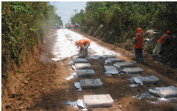
FIG. 4.11. Colocación de las bolsas de cal sobre el material de subrasante en un tramo de carretera.
