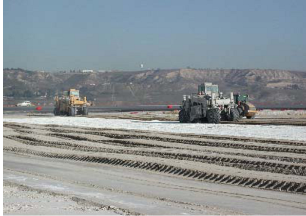
FIG. 2.35 Estabilización de suelos con cal.
