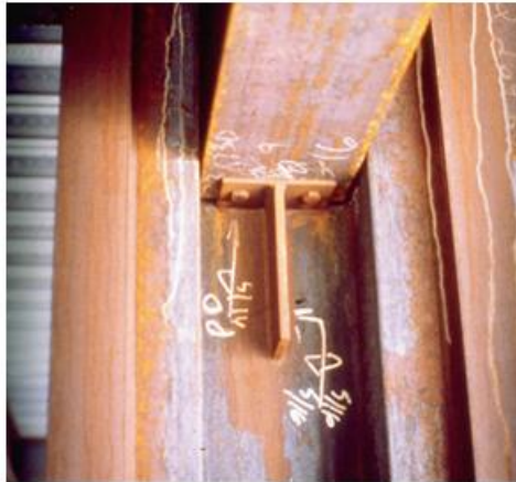
Fig. 7.36 Conexión atornillada con perfil T atiesado.
