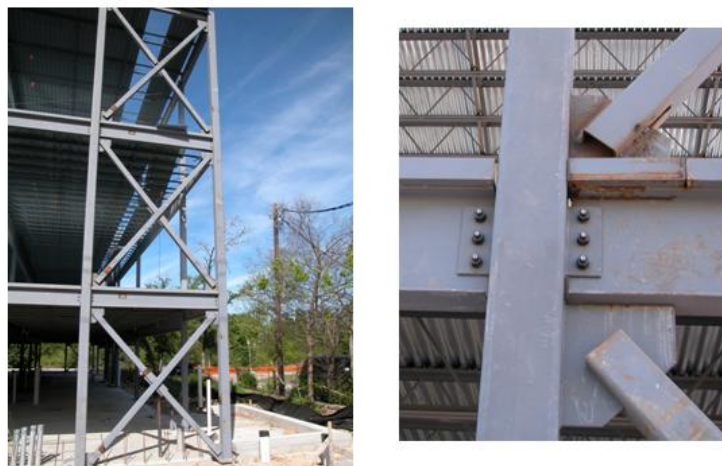
Fig. 7.39 Conexión diagonal de contraventeo.
