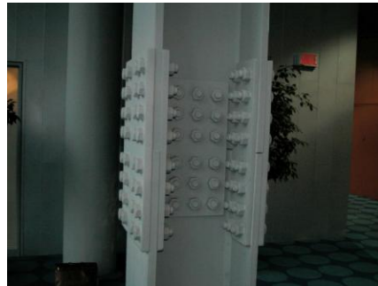
Fig. 7.40 Conexión emperrada para empalmes de columnas.
