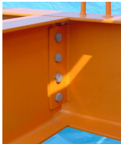
Fig. 7.31 Placas simples para vigas de igual peralte.
