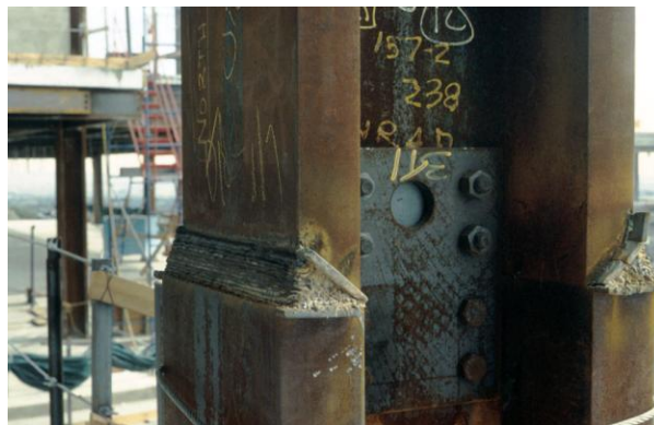
Fig. 7.41 Conexión soldada para empalmes de columnas.
