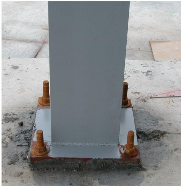
a) Conexión para condición articulada
