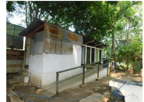
2. Servicios sanitarios y duchas
