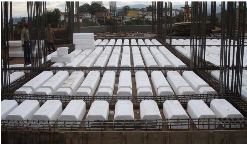
Figura 2. 75 Losa aligerada.
