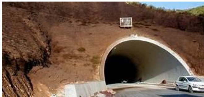
Figura 2. 10 Túnel de concreto reforzado.
