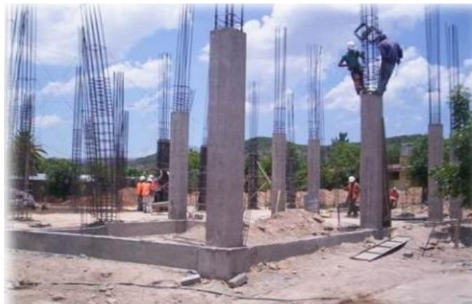
Figura 2. 66 Columnas de concreto reforzado.
