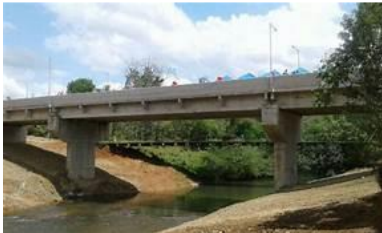
Figura 2. 8 Puente de concreto reforzado.
