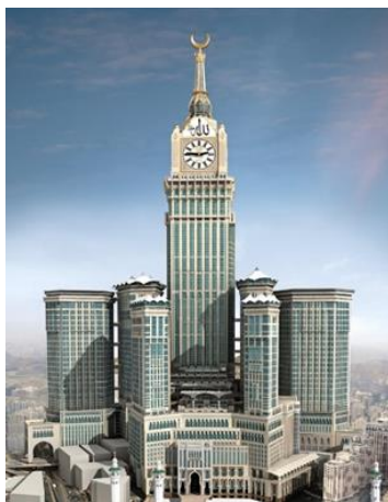
Figura 2. 3 Edificio Torres Abraj Al B.
