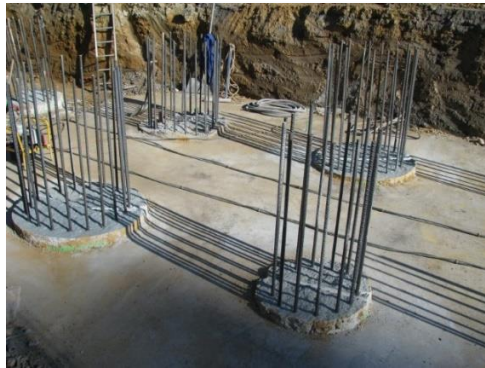
Figura 2. 59 Descabezado de pilotes.
