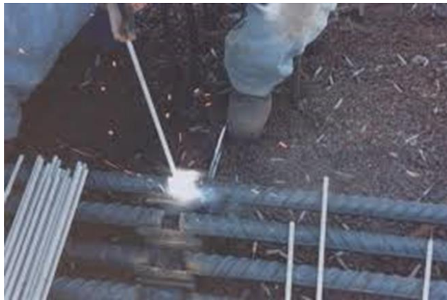
Figura 2. 86 Soldadura de varillas de acero en campo.
