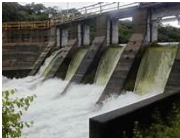
Figura 2. 9 Presa de concreto reforzado.
