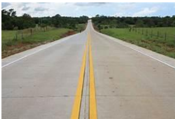
Figura 2. 7 Carretera de concreto hidráulico.
