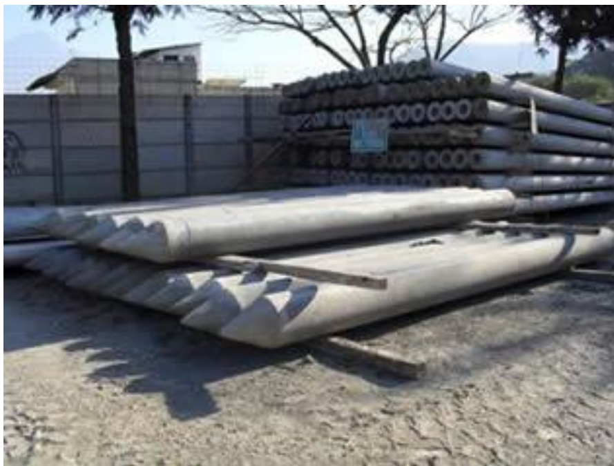
Figura 2. 54 Pilotes prefabricados.
