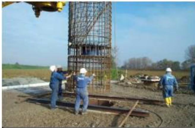
Figura 2. 58 Colocación del refuerzo para en vaciado posterior.
