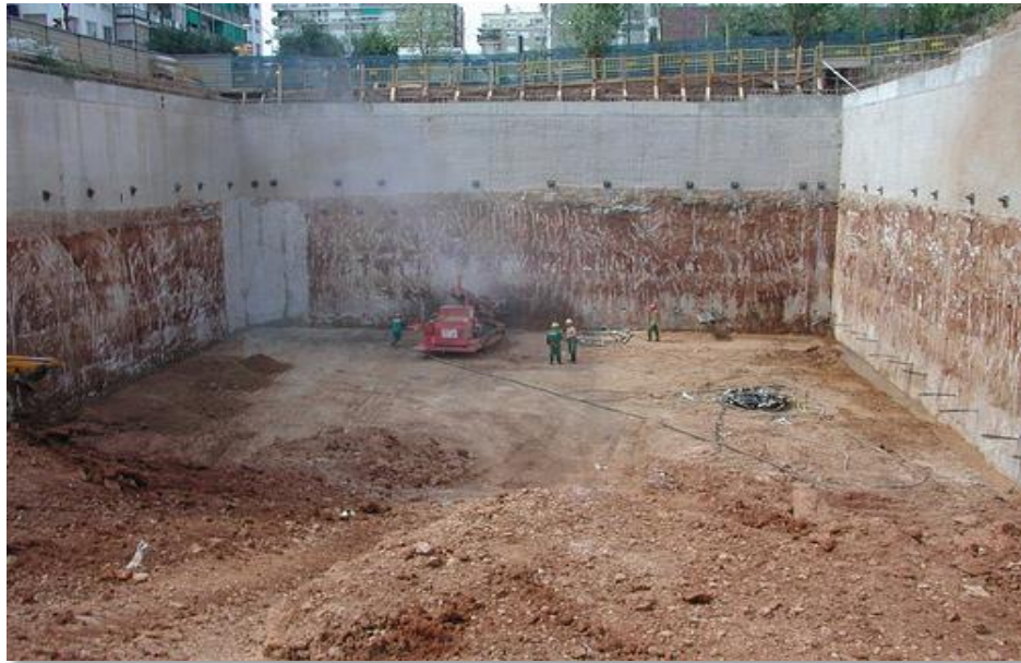
Figura 2. 50 Cimentación profunda de muros pantalla.
