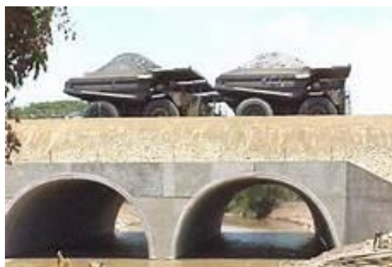
Figura 2. 11 Bóveda de concreto reforzado.
